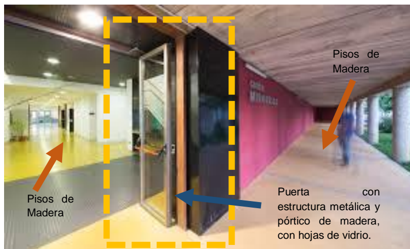
Figura 18. “Centro Ocupacional de Sanjuanejo” – Acabados
