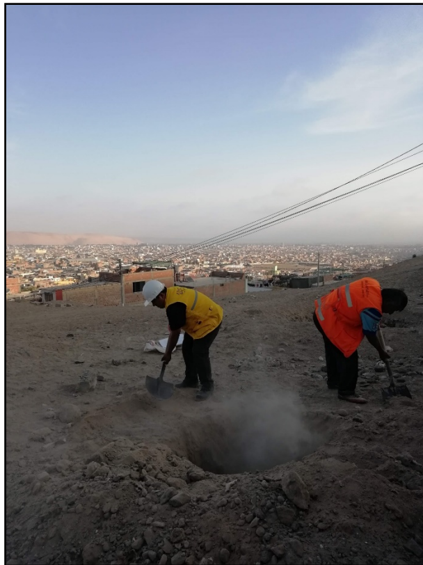
Tapado de calicatas
