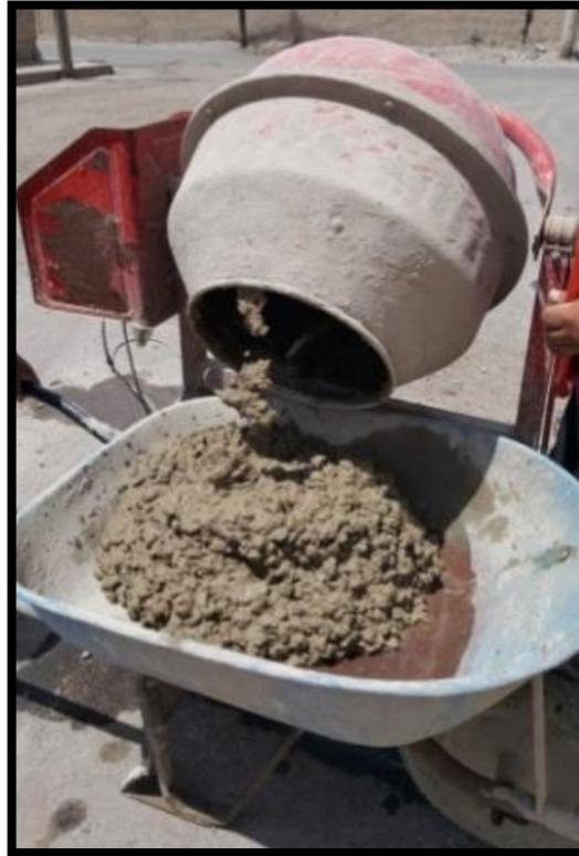
**Figura 14.** Mezclado de concreto
