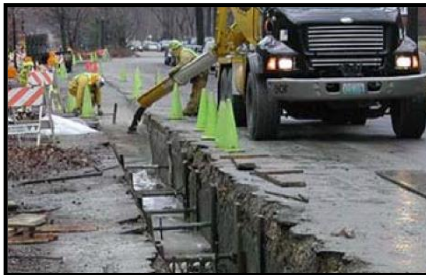
Imagen 10 Relleno con concreto fluido en una zanja
