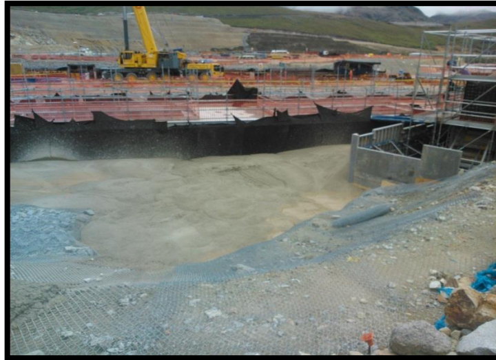
Imagen 09 Relleno con concreto fluido al exterior del túnel de recuperación
