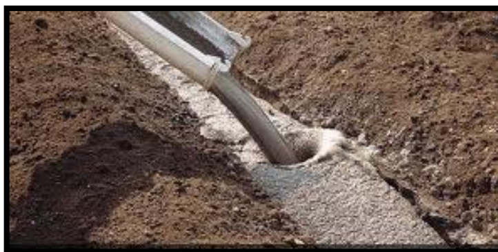
Relleno con Concreto Fluido
