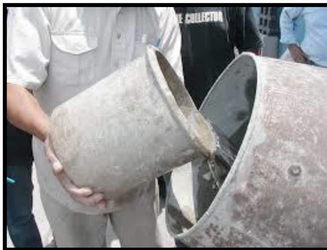
Imagen 05 Agua para construcción
