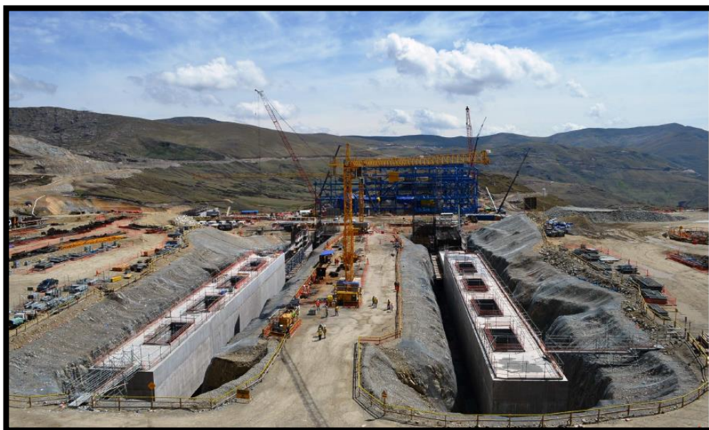
Imagen 27 Túneles de Recuperación y Acopio de Material del Proyecto “Las Bambas”
