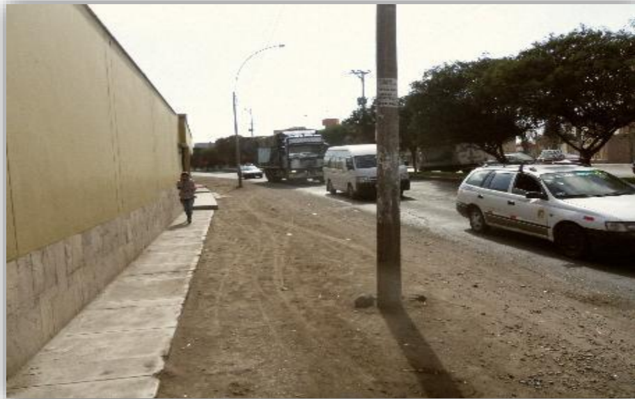
ESQUINA DE AV. JORGE BASADRE G. CON AV. GREGORIO ALBARRACIN SE OBSERVA LA AV. JORGE BASADRE G. EN LA VIA DE BAJADA, DONDE SE OBSERVA EL TERCER CARRIL PROPUESTO EN LAS SECCIONES DEL PLAN VIAL, SE APRECIA QUE AUN ESTA CON TIERRA.
