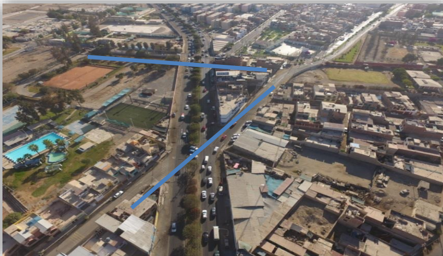
FIGURA N° 03: Zona de Intervención, Intersección de la Av. Jorge Basadre G. con Av. Leguía
