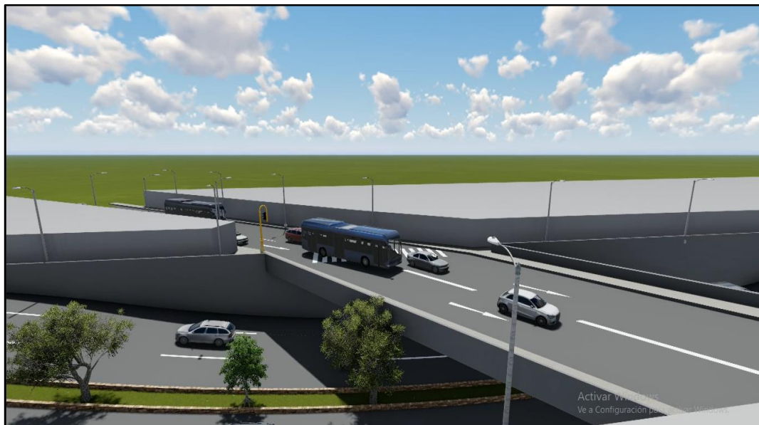
FIGURA N° 59: Paso a desnivel de la Av. Jorge Basadre G. anulado la intersección genera flujo libre; Propuesta de Mejora 3 FUENTE: Elaboración Propia
