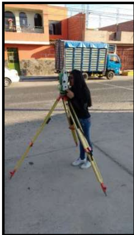
Ilustración 14: “En la fotografía observamos la toma de puntos topográficos desde la Estación Total” Fuente: “Propia”
