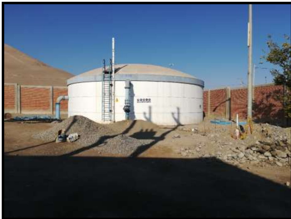
Ilustración 2: “Reservorio R-13 (vol.=450 m3), se encuentra a un costado del reservorio R-11” Fuente: “Propia”
