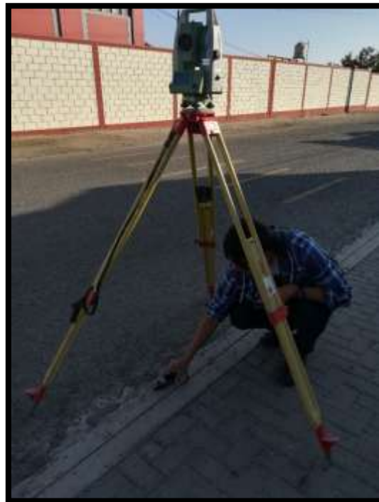
Ilustración 4: “Con el apoyo del GPS Navegador nos orientamos la posición de la Estación Total, coordenadas UTM WGS 84”
