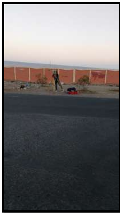
Ilustración 17: “En la imagen toma de puntos con la Estación Total en la Avenida Perimetral 02” Fuente: “Propia”
