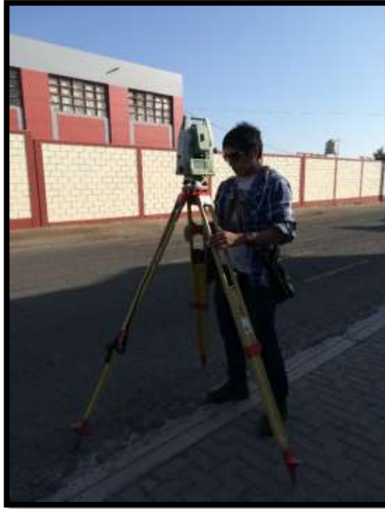
Ilustración 3: “Empezamos a estacionar (estación N° 01) el equipo topográfico Leica TS06”
