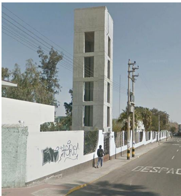
Figura 4. Reservorio elevado I.E Francisco Antonio de Zela
