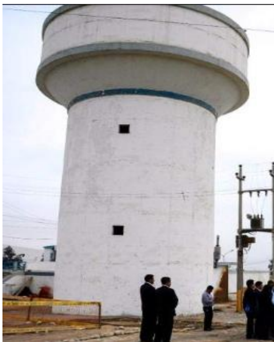
Figura 6. Reservorio elevado EPS Tacna
