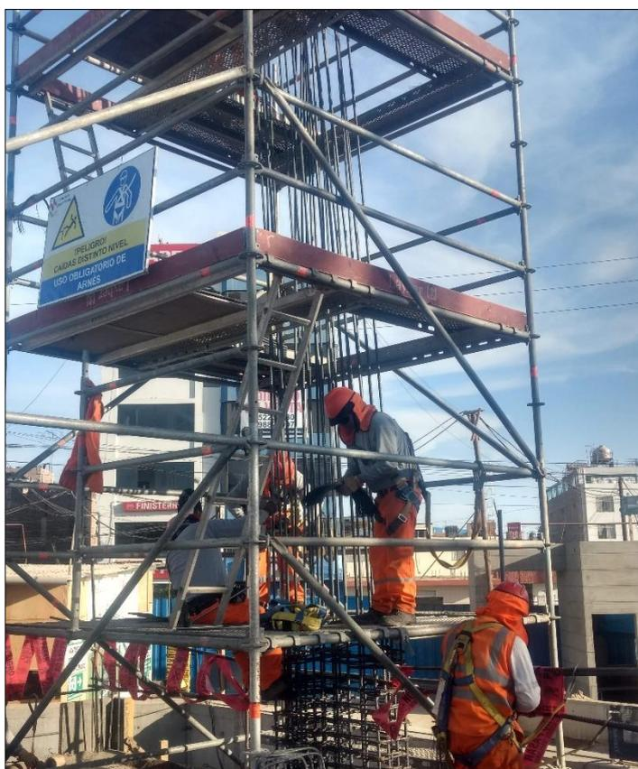
**Figura 3.14** Utilización de andamios para el proceso de Colocación de acero corrugado en Columnas. (Fuente: Elaboración Propia)
