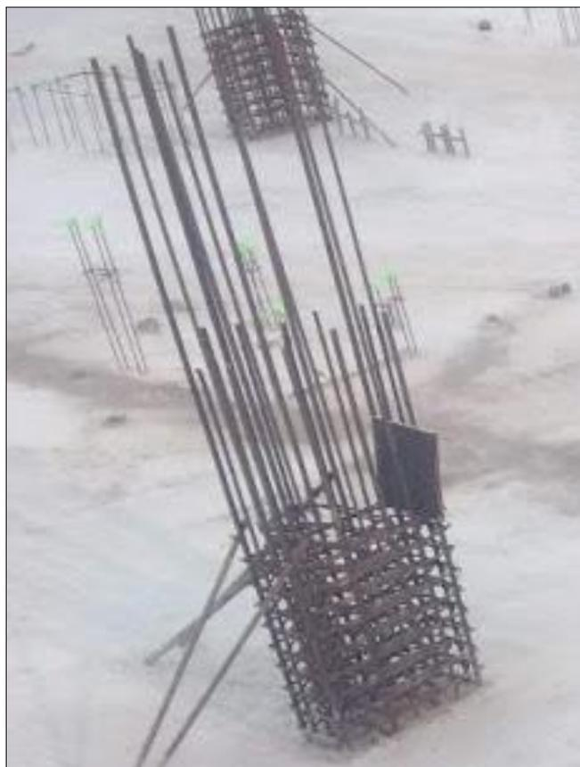
**Figura 3.13** Arranque de columna en losa maciza. (Fuente: Elaboración Propia)
