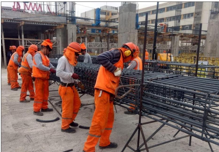
**Figura 3.16** Cuadrilla de trabajadores encargada del subproceso de Prearmado de Armaduras de Acero. (Fuente: Elaboración Propia)
