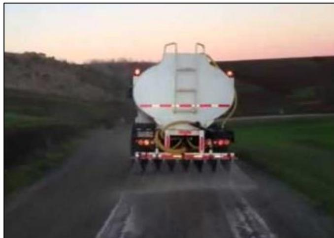
Figura N° 06: Riego con cloruro de sodio y/o sal.
