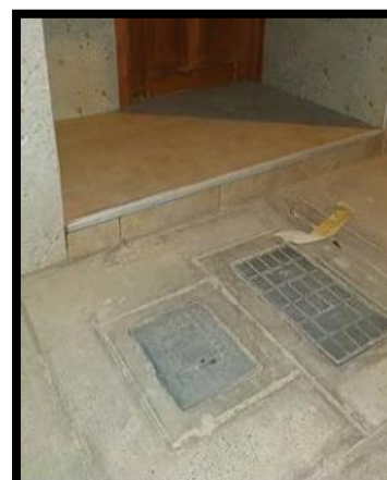
Fotografía 30: Micromedidor de la Mz. H – lote 21.
