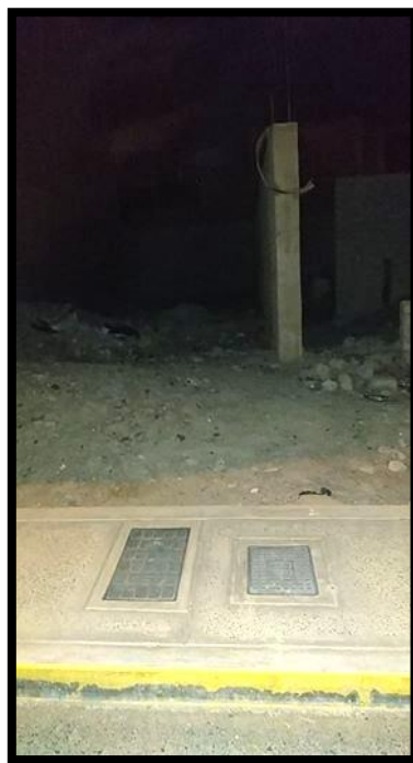
Fotografía 49: Fachada de la vivienda de la Mz. 81– lote 6.
