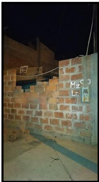
Fotografía 68: Fachada de la vivienda de la Mz. 99– lote 1.
