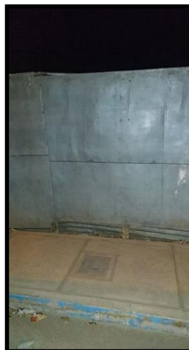
Fotografía 43: Fachada de la vivienda de la Mz. 83– lote 7.
