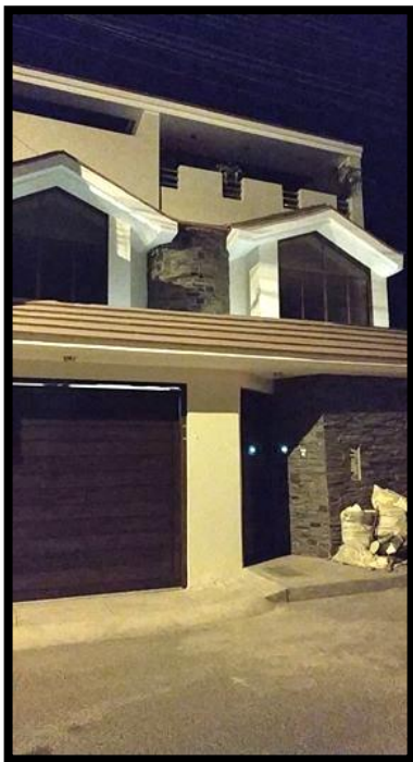
Fotografía 76: Fachada de la vivienda de la Mz. 97– lote 11.
