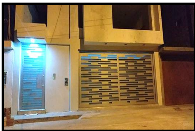
Fotografía 78: Fachada de la vivienda de la Mz. 100– lote 13.
