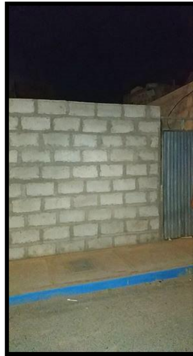
Fotografía 61 Fachada de la vivienda de la Mz. 80– lote 14.
