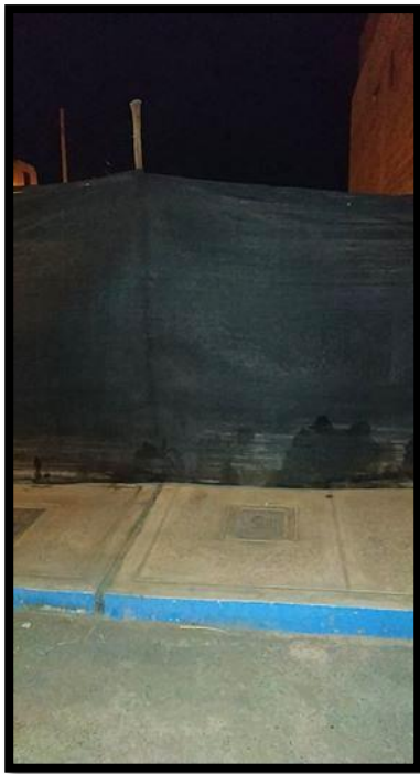
Fotografía 60: Fachada de la vivienda de la Mz. 80– lote 12.
