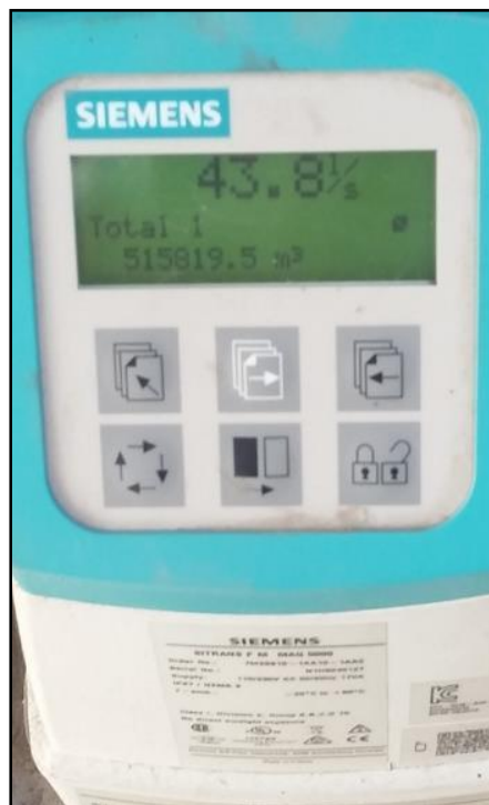
Fotografía 17: Vista de la lectura del macromedidor.
