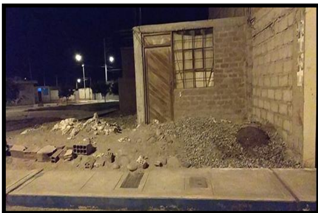
Fotografía 82: Fachada de la vivienda de la Mz. 100– lote 8.
