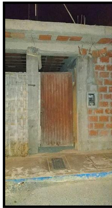
Fotografía 63: Fachada de la vivienda de la Mz. 98– lote 13.
