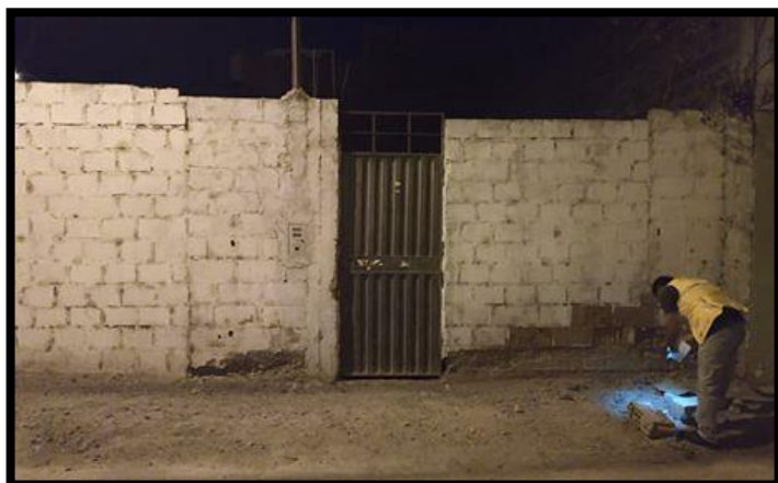
Fotografía 23: Fachada de la vivienda de la Mz. 42 – lote 23.
