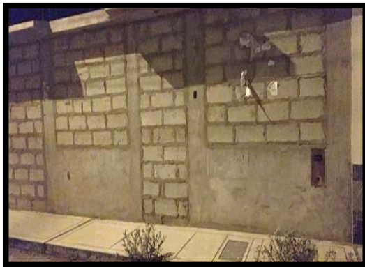
Fotografía 88: Fachada de la vivienda de la Mz. 102– lote 15.
