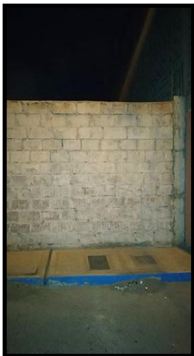
Fotografía 64: Fachada de la vivienda de la Mz. 98– lote 11.
