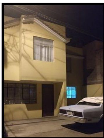
Fotografía 31: Fachada de la vivienda de la Mz. C– lote 16.
