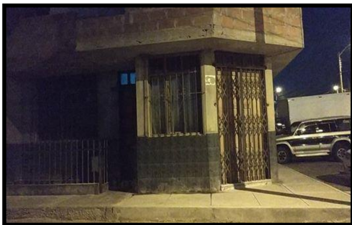
Fotografía 19: Fachada de la vivienda de la Mz. 43 – lote 12.
