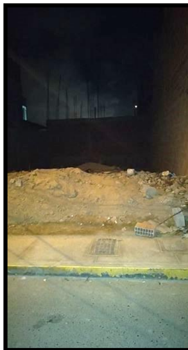
Fotografía 47: Fachada de la vivienda de la Mz. 83– lote 19.
