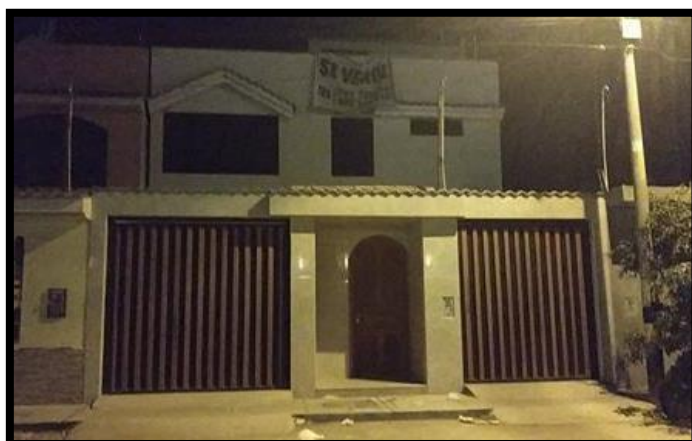
Fotografía 29: Fachada de la vivienda de la Mz. H– lote 21.
