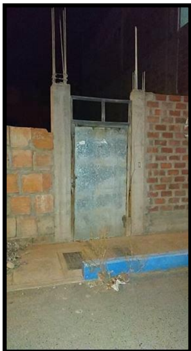
Fotografía 46: Fachada de la vivienda de la Mz. 83– lote 3.
