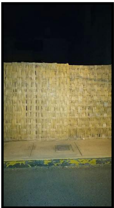
Fotografía 48: Fachada de la vivienda de la Mz. 83– lote 17.
