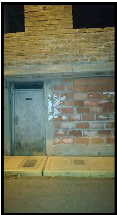
Fotografía 52: Fachada de la vivienda de la Mz. 81– lote 3.
