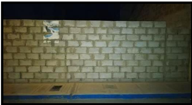
Fotografía 72: Fachada de la vivienda de la Mz. 97– lote 4.
