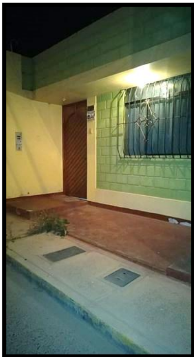
Fotografía 74: Fachada de la vivienda de la Mz. 97– lote 14.
