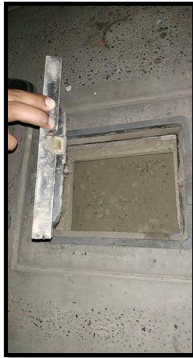
Fotografía 57: Micromedidor de la Mz. 82 – lote 14.
