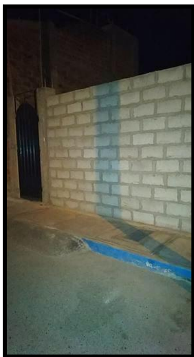
Fotografía 70: Fachada de la vivienda de la Mz. 97– lote 2.
