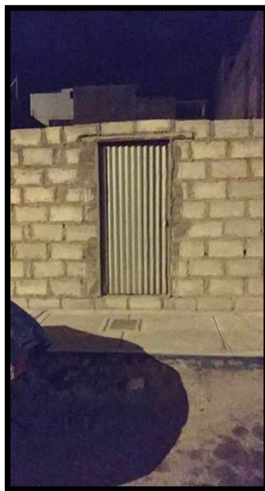
Fotografía 53: Fachada de la vivienda de la Mz. 81– lote 13.
