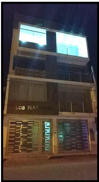
Fotografía 58: Fachada de la vivienda de la Mz. 80– lote 4.
