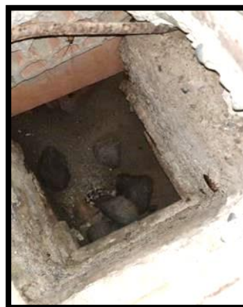
Fotografía 41: Micromedidor de la Mz. 83 – lote 5.
