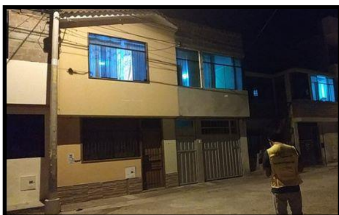
Fotografía 25: Fachada de la vivienda de la Mz. 41 – lote 11.
