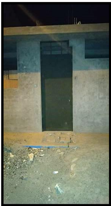
Fotografía 44: Fachada de la vivienda de la Mz. 83– lote 4.
