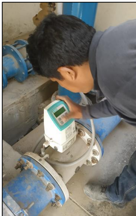
Fotografía 16: Toma de datos de la lectura de los macromedidores.
