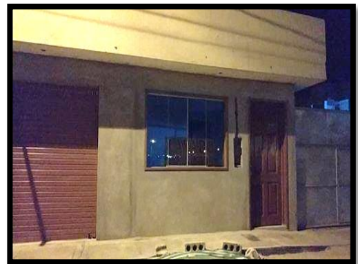
Fotografía 89: Fachada de la vivienda de la Mz. 102– lote 12.
