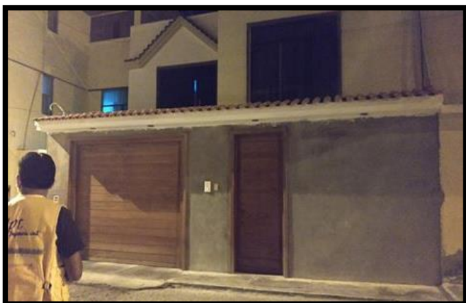
Fotografía 40: Fachada de la vivienda de la Mz. 83– lote 5.
