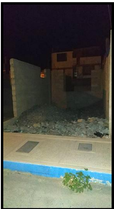
Fotografía 66: Fachada de la vivienda de la Mz. 98– lote 3.
