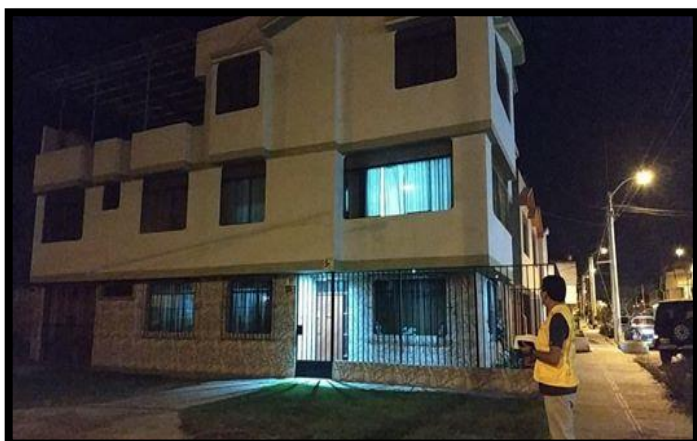
Fotografía 27: Fachada de la vivienda de la Mz. E – lote 10.
