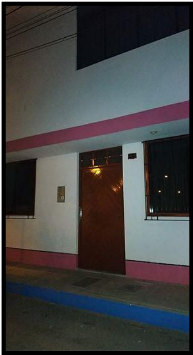
Fotografía 56: Fachada de la vivienda de la Mz. 82– lote 14.
