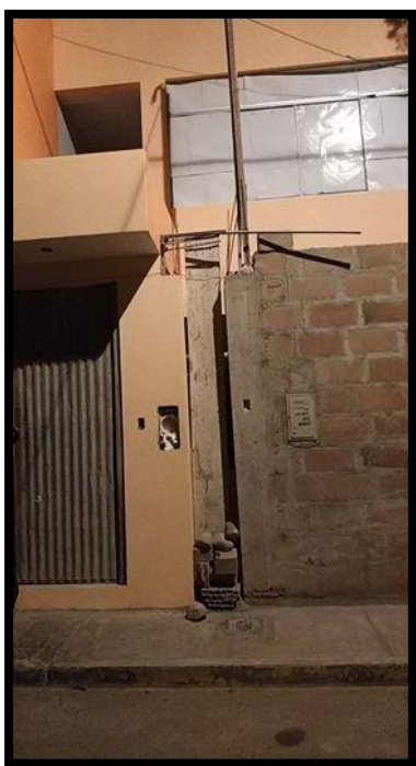
Fotografía 54: Fachada de la vivienda de la Mz. 82– lote 5.
