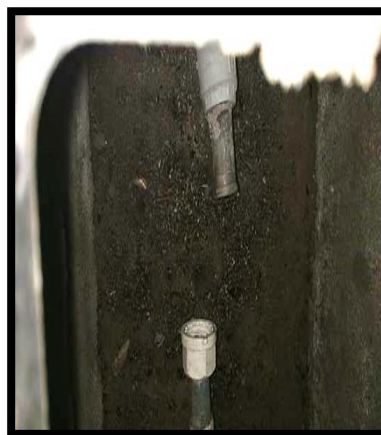
Fotografía 83: Micromedidor de la Mz. 100 – lote 8.
