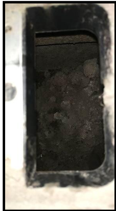
Fotografía 73: Micromedidor de la Mz. 97 – lote 4.
