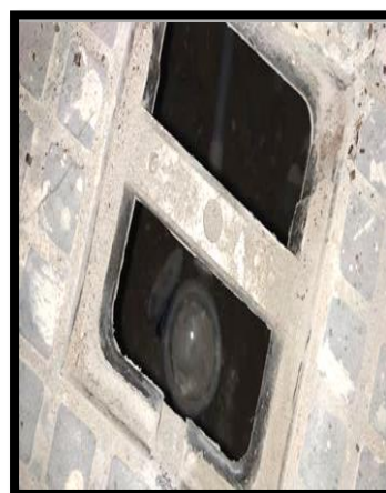
Fotografía 39: Micromedidor de la Mz. 102 – lote 10.
