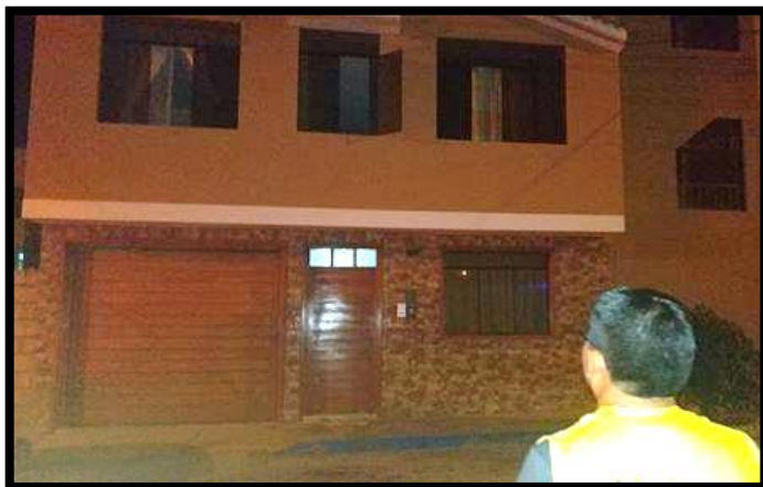
Fotografía 34: Fachada de la vivienda de la Mz. 81– lote 12.
