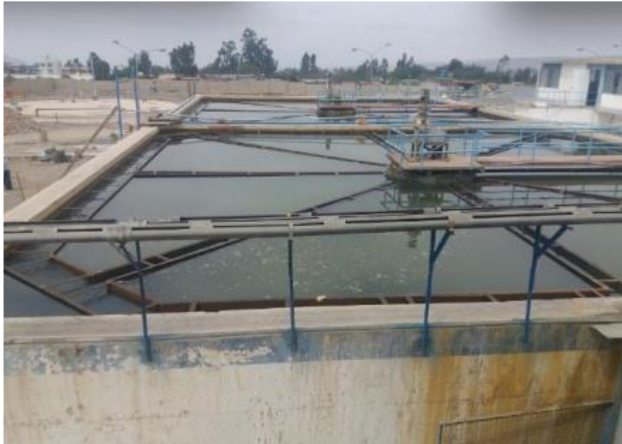
Fotografía 1 : Infraestructura de la planta de Tratamiento de Calana.
