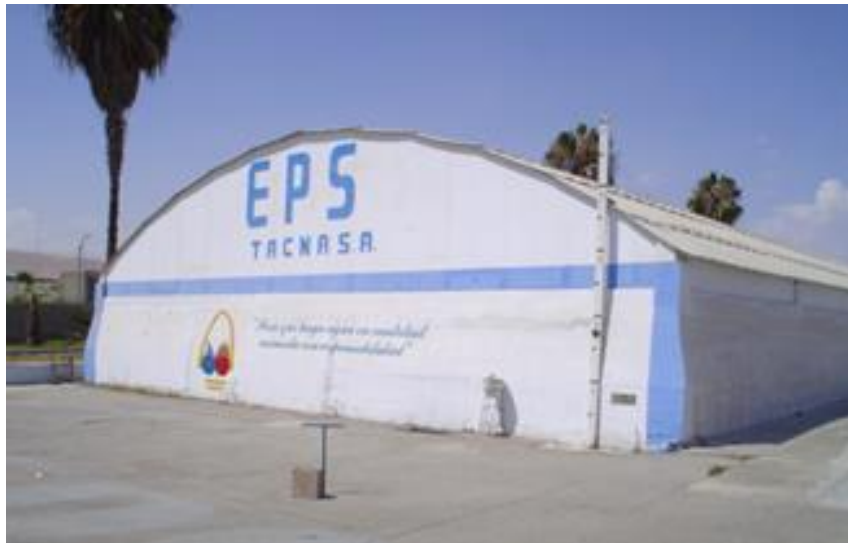
Fotografía 8 : Reservorio 4 ubicado en la planta de tratamiento de Alto Lima
