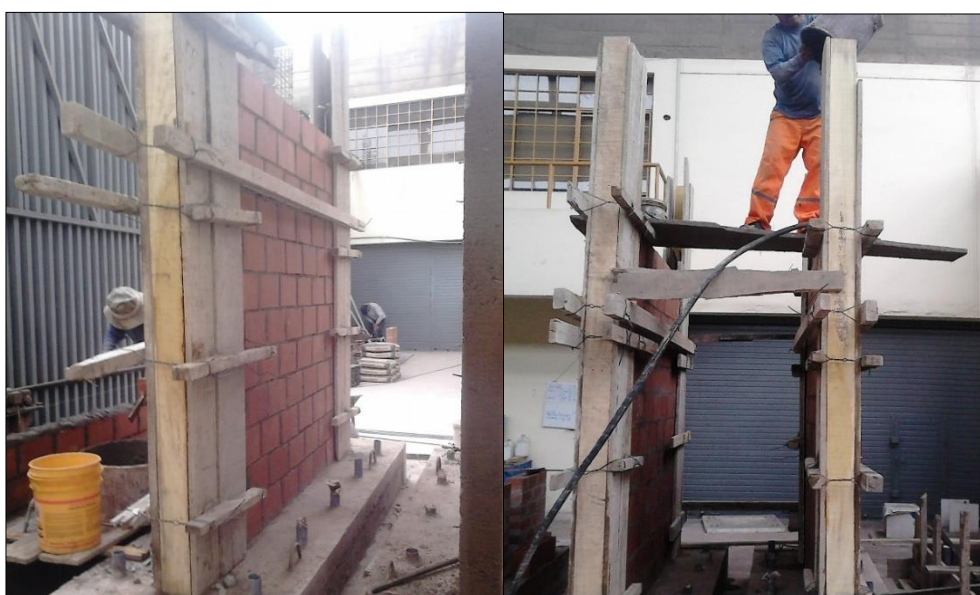
Fig. 3- 9: Encofrado y Vaciado de la Columna.
