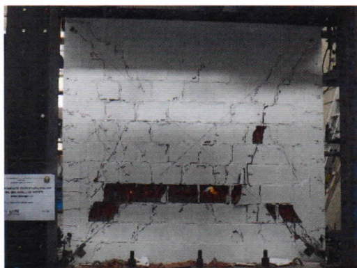
Foto 35. Desprendimiento de 2 ladrillos en la parte Oeste inferior de la cara Norte para una distorsión de 1/150 en el 2° ciclo.
