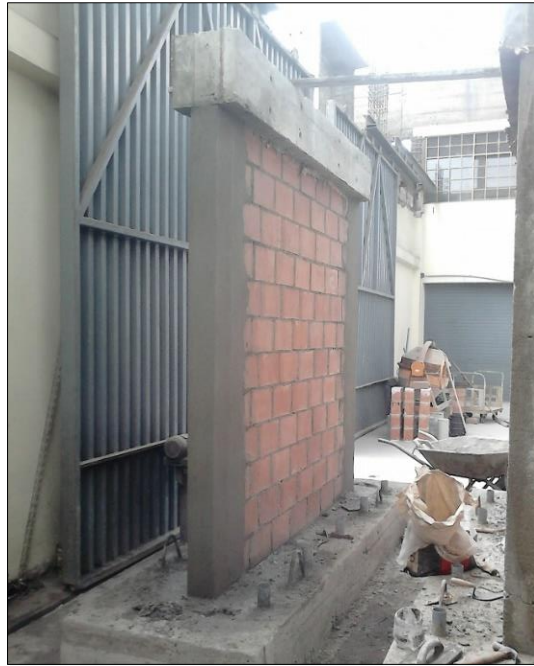
Fig. 3- 12: Curado y el solaqueo de la estructura.
