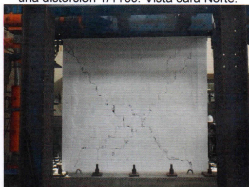
Foto 4. Continuación de grietas diagonales y aparición de nuevas grietas diagonales en la parte inferior oeste y superior este en el mortero para una distorsión 1/800. Vista cara Sur.
