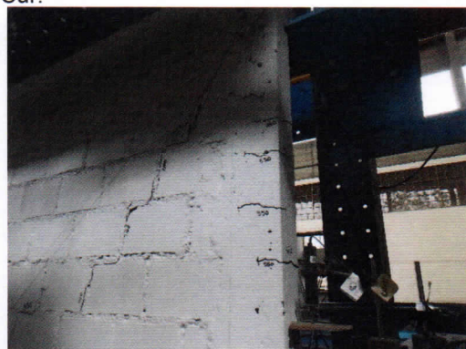
Foto 6. Aparición de grietas por flexión en la parte media y superior de la columna Oeste para una distorsión de 1/550.
