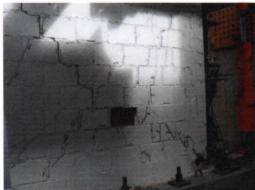
Foto 21. Desprendimiento de toda la cara de un ladrillo en la parte central de la cara Norte para una distorsión de 1/300 en el 2° ciclo.
