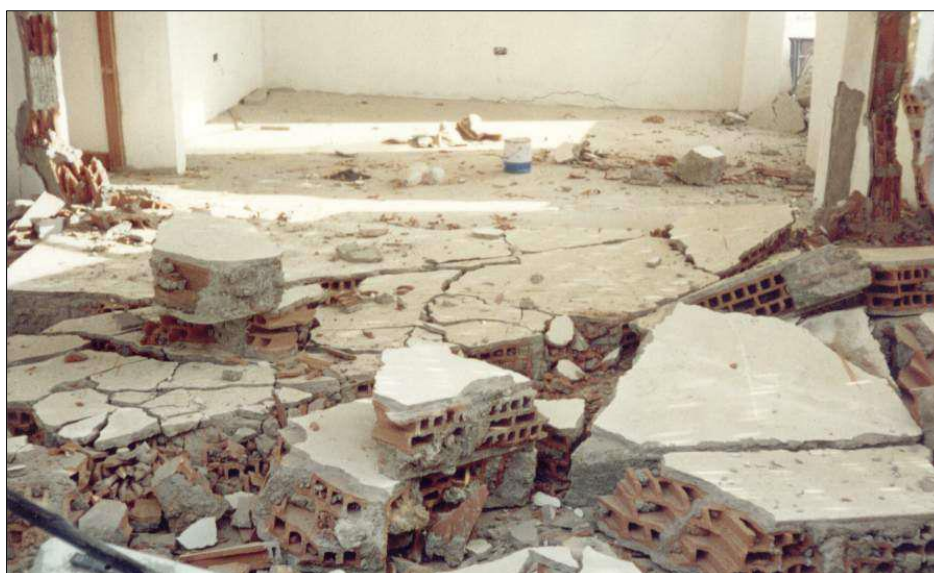
Fig. 1-2: Colapso de vivienda debido al sismo del 23 de junio del año 2001 en Tacna.
