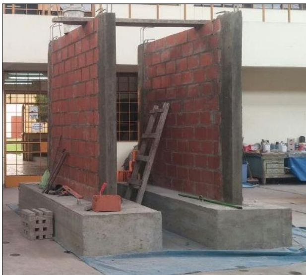
Fig. 3- 10: Muro con columnas fraguadas y desencofradas.
