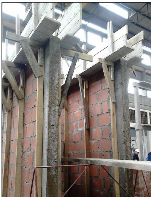
Fig. 3- 11: Encofrado de vigas.
