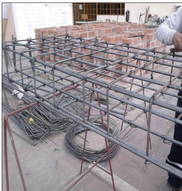
Fig. 3- 3: Habilitación del acero
