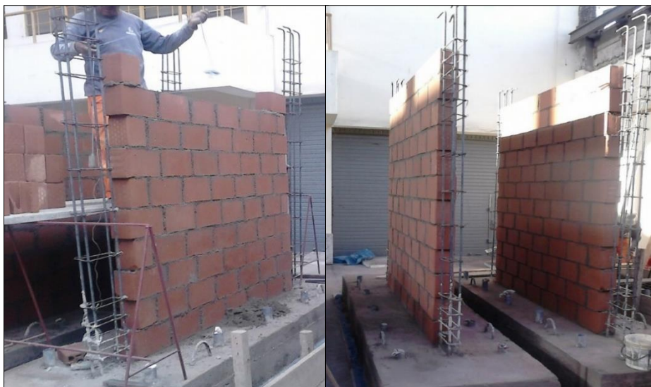
Fig. 3- 8: Culminación de Asentado de Unidades de Albañilería.
