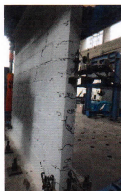
Foto 12. Aparición de grietas por flexión en la parte media e inferior de la columna Oeste para una distorsión de 1/400.
