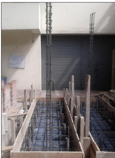
Fig. 3- 5: Colocación de acero de columnas.
