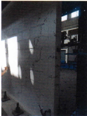
Foto 44. Formación de grietas por flexión en la parte central e inferior de la columna Oeste para una distorsión de 1/1100.
