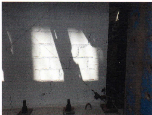
Foto 36. Formación de grietas diagonales en el mortero hasta antes de la parte central en la parte inferior Oeste de la cara Norte para una distorsión 1/1500.
