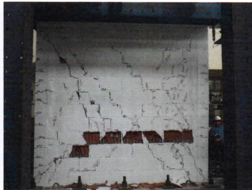
Foto 32. Desprendimiento de un ladrillo en la parte central Oeste de la cara Sur para una distorsión de 1/150 en el 1° ciclo.
