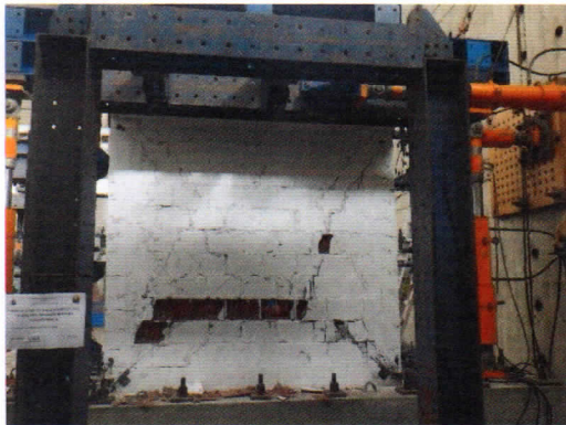
Foto 33. Desprendimiento de 2 ladrillos en la parte Este central e inferior de la cara Norte para una distorsión de 1/150 en el 1° ciclo al descargar.
