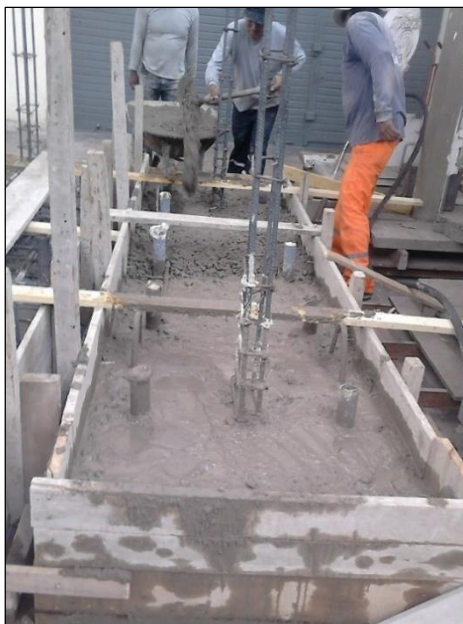
Fig. 3- 6: Vaciado del concreto.
