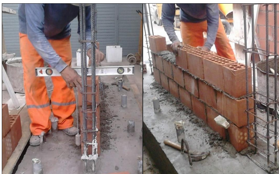
Fig. 3- 7: Asentado de ladrillos y verificación de verticalidad del muro.
