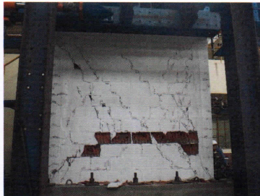
Foto 34. Desprendimiento de un ladrillo en la parte inferior Este de la cara Sur para una distorsión de 1/150 en el 2° ciclo.
