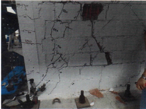
Foto 84. Desprendimiento de ladrillo de la Foto 82 (parte central Este de la cara Norte) para una distorsión de 1/200.
