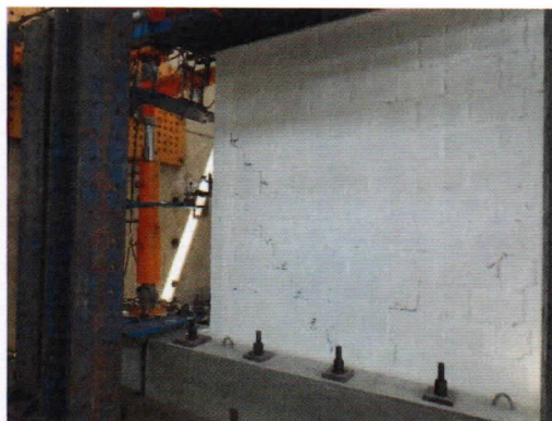
Foto 37. Formación de grietas diagonales en el mortero hasta antes de la parte central en la parte superior e inferior Oeste de la cara Sur para una distorsión 1/1500.
