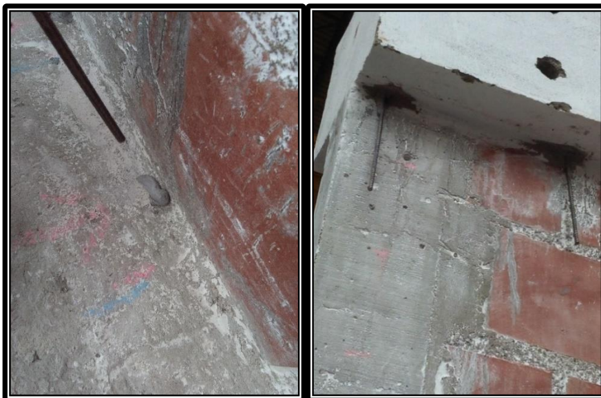
Fig. 3-10 Colocación de Bastones Guías.
