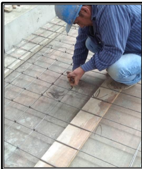
Fig. 3-6. Atortolado de la Malla de Acero con Alambre negro N°16.
