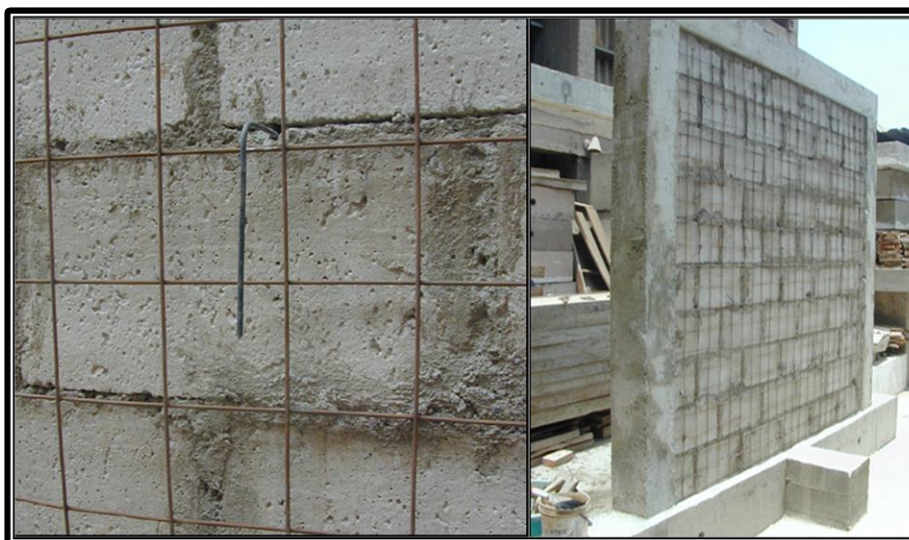
Fig. 5-4. Panel de Malla Instalada
