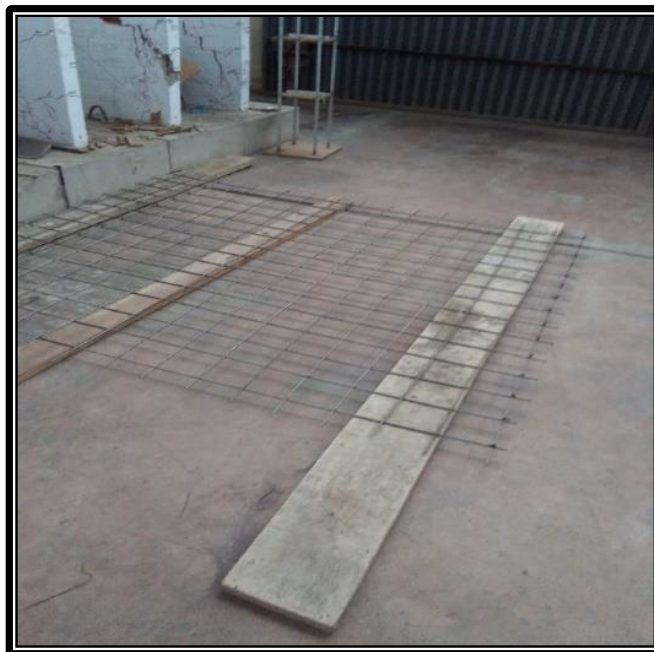
Fig. 3-3. Distribución de los Bastones de Acero.
