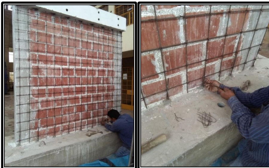
Fig. 3-11. Atortolado de la Malla de Acero con Bastones Guías.
