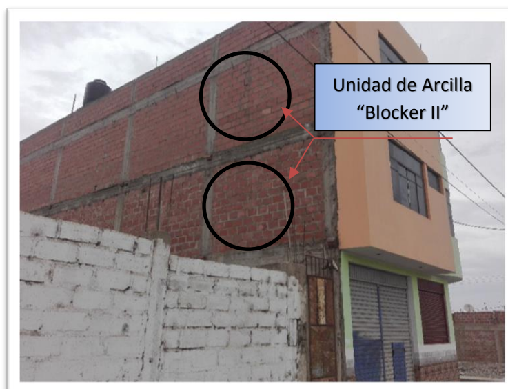
Fig. 1-1 Vivienda con Unidad de Arcilla “Blocker II” en Tacna.
