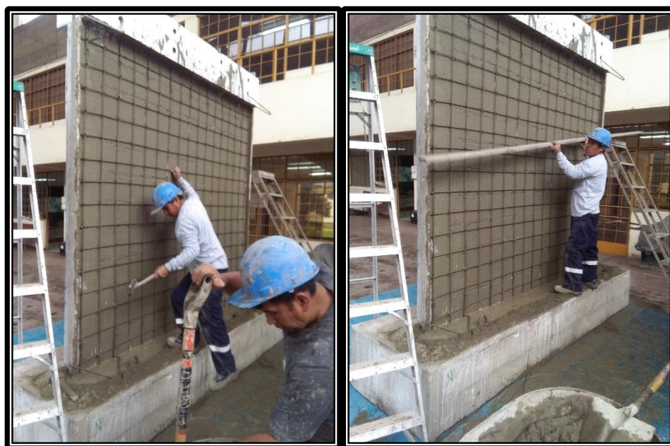
Fig. 3-15. Trabajo de Revestimiento y Tarrajeo
