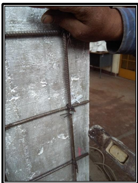
Fig. 3-12. Colocación de ganchos de Sujeción.
