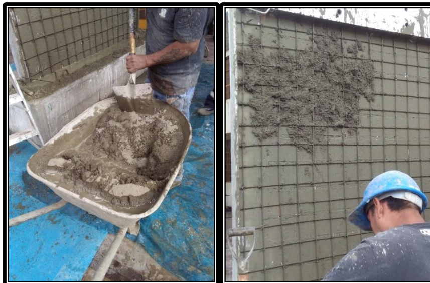
Fig. 3-14. Colocación del Mortero para el Revestimiento del Muro.
