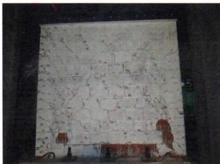
Foto 17. Desprendimiento de ladrillo en la parte inferior del muro para la distorsión 1/150 Vista cara Sur.
