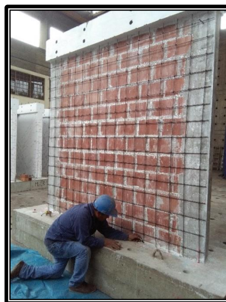
Fig. 3-13. Malla de Acero de 6mm Instalada en el Muro.
