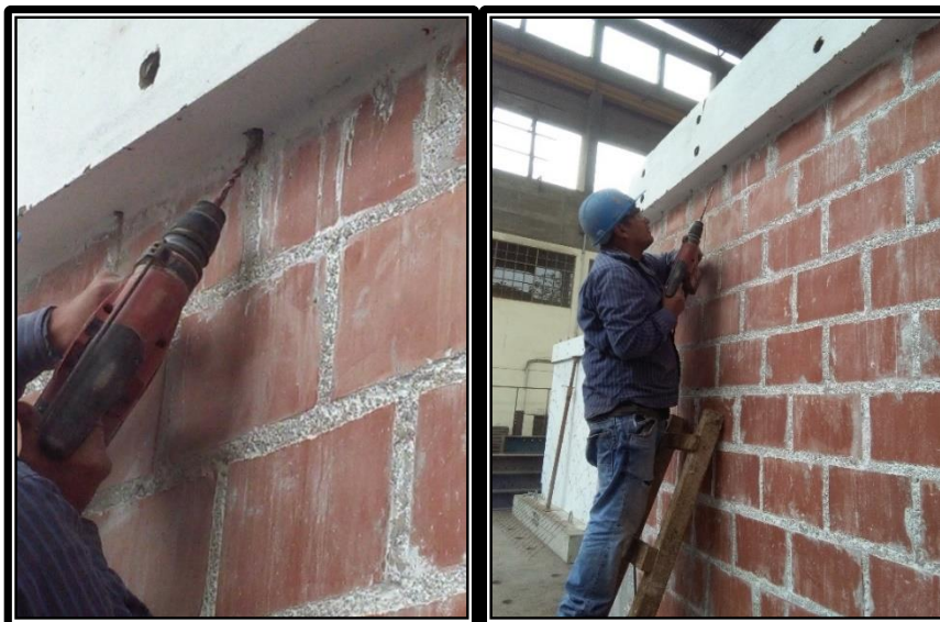
Fig. 3-7. Perforaciones en la Viga para los Bastones Guía.
