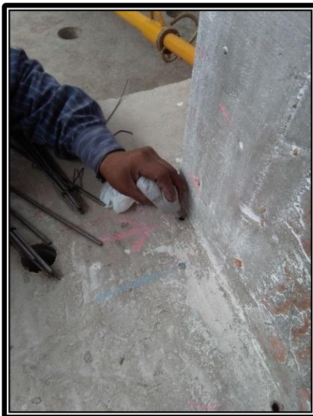
Fig. 3-9. Colocar la Mezclar en las Perforaciones.
