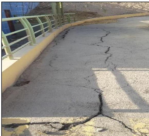
**Foto N° 9: Fisuras y grietas en la vía (carpeta asfáltica) del circuito car, así como la deformación existente.**
