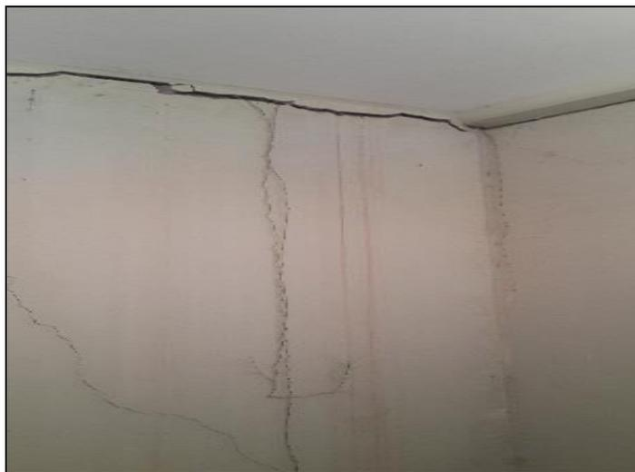
**Foto N° 6: Fisuras en muros de servicios higiénicos**
