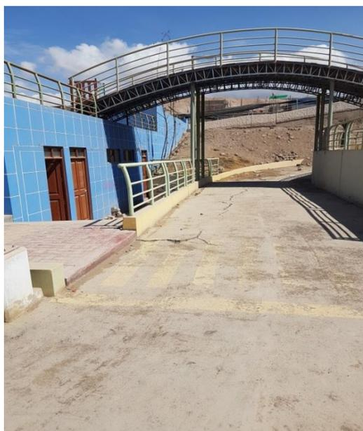
**Foto N° 16, Circuito de car con presencia de fisuras en desuso – Frente de Servicios higiénicos**
