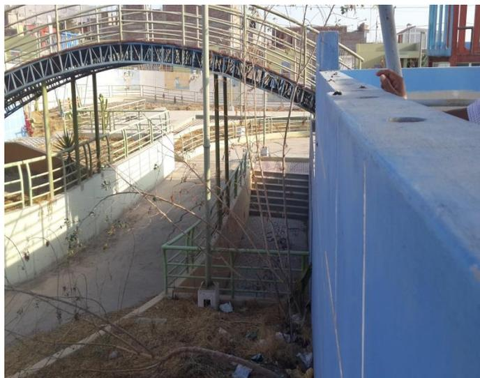
**Fotos N° 11 y 12, Se observa el desplazamiento del muro (Lateral izquierdo de los SS.HH. N° 3).**
