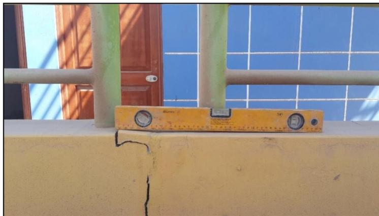
**Foto N° 14, Desplazamiento del muro de contención – zona de car.**
