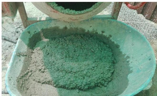
Figura 28: Consistencia de la mezcla.
