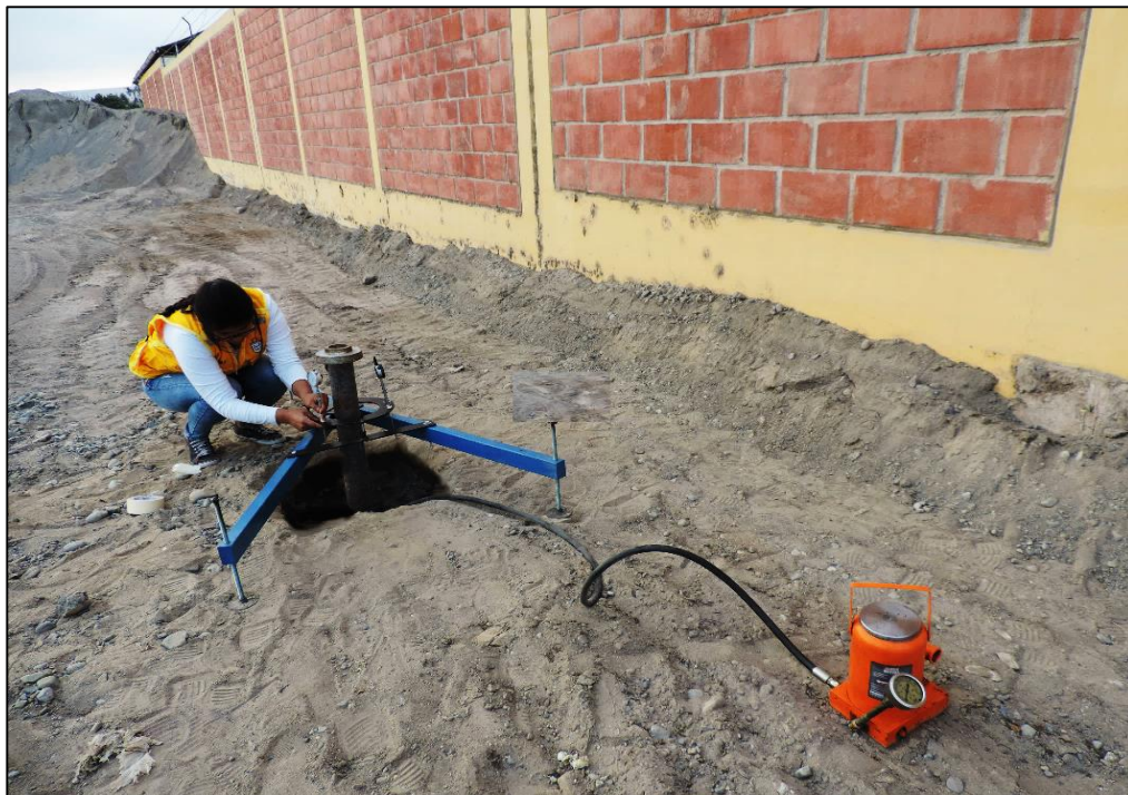
Fotografía 14. Colocación de los diales y bomba hidráulica.
