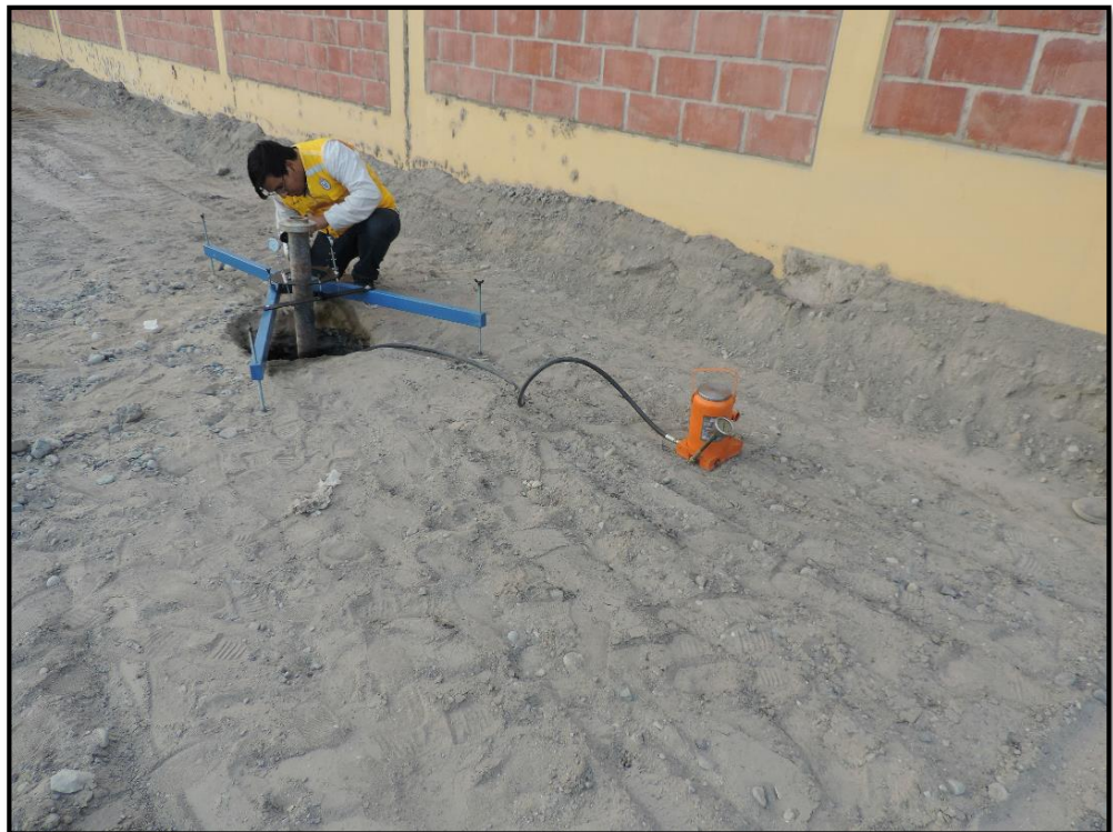
Fotografía 16. Ajuste del equipo en la calicata.
