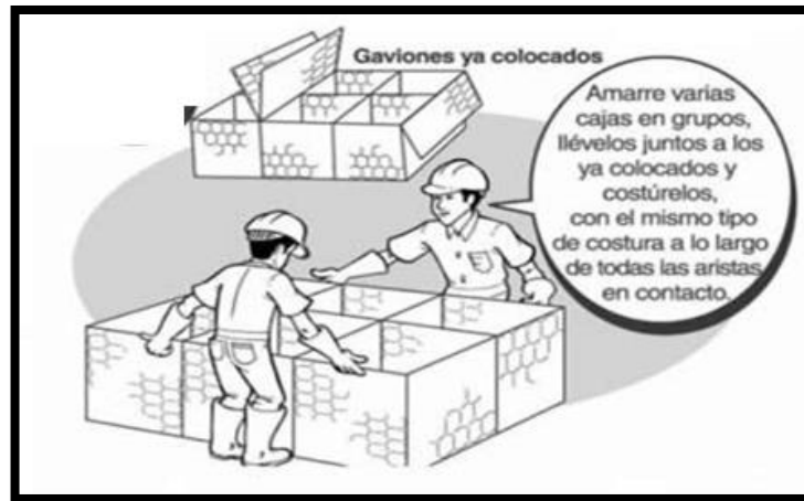
Figura N° 23: Alineamiento de cajas.
