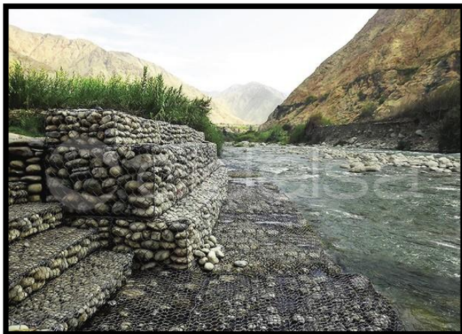
Figura N° 16: Muros de gaviones utilizados como protección ribereña. Fuente: Cañete - Perú Defensa ribereña con gaviones colchón y caja.
