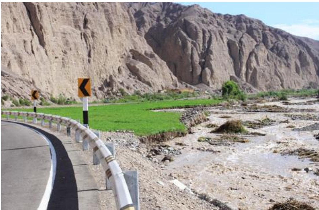
FOTO N°08: SE OBSERVA EL CAUDAL DEL RIO LOCUMBA EN EPOCAS DE VENIDAS PROGRESIVA 6+840 DEL TRAMO CP.MIRAVE- OCONCHAY, NOVIEMBRE DEL 2014.
