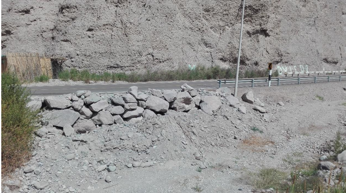
FOTO N°05: SE OBSERVA UN MURO SECO EN EL TRAMO DE PROPUESTA DEL MURO DE GAVIONES PROGRESIVA 6+840 DEL TRAMO CP.MIRAVE- OCONCHAY.
