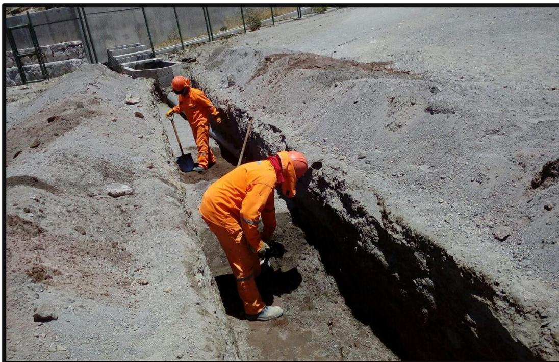
**Foto 1:** Excavación Manual en Terreno.
