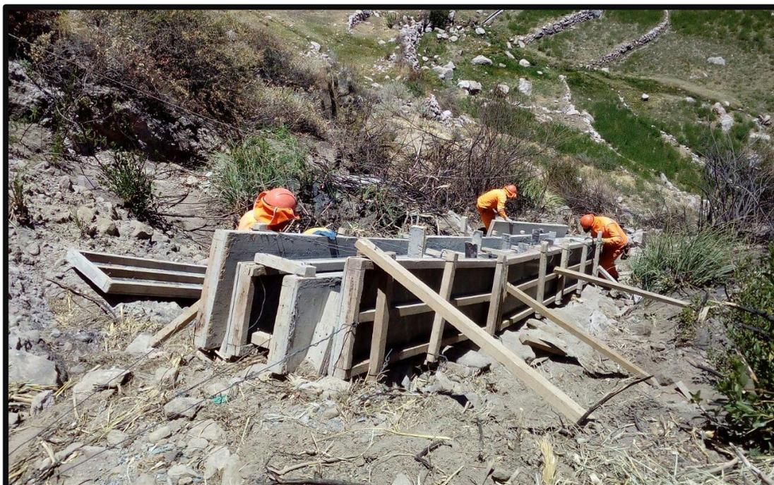
**Foto 2:** Desencofrado de canal.
