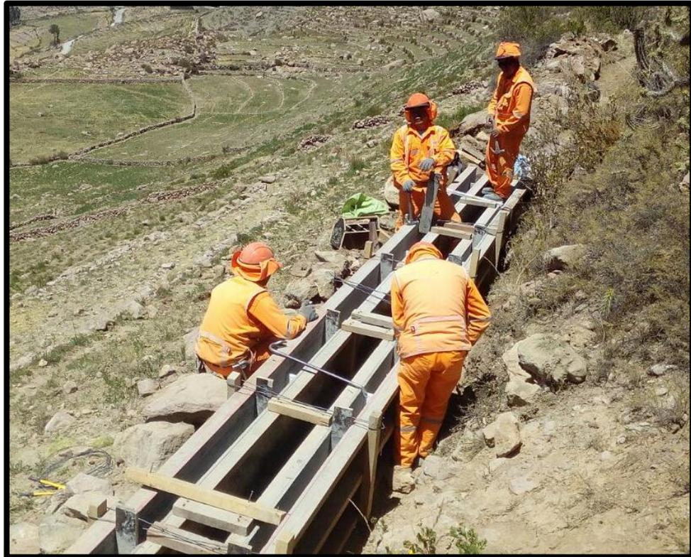
**Figura 26:** Encofrado de madera.
