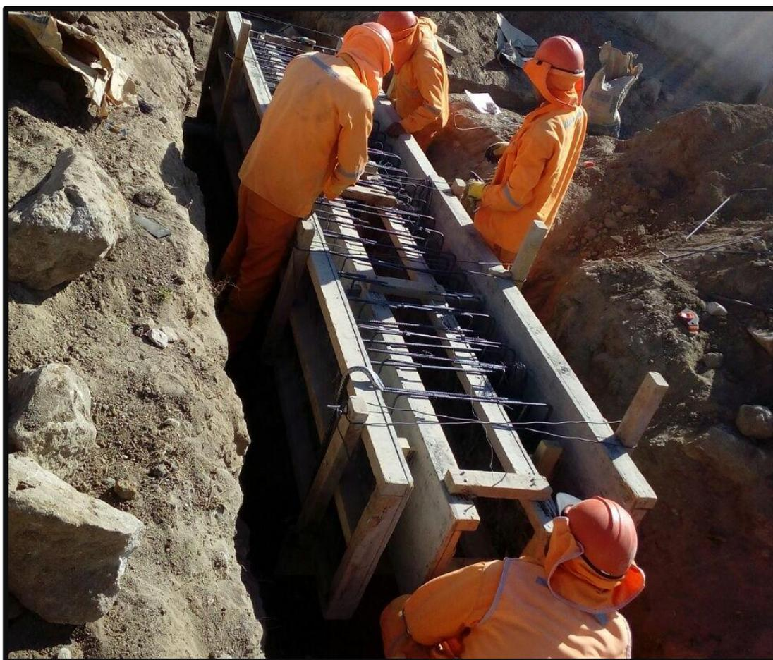
**Foto 8:** Encofrado de Canal
