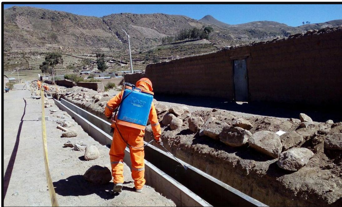
**Foto 7:** Curado de la estructura del canal.
