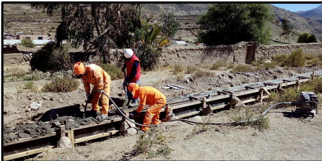
**Foto 4:** Vibrado de la mezcla de concreto.
