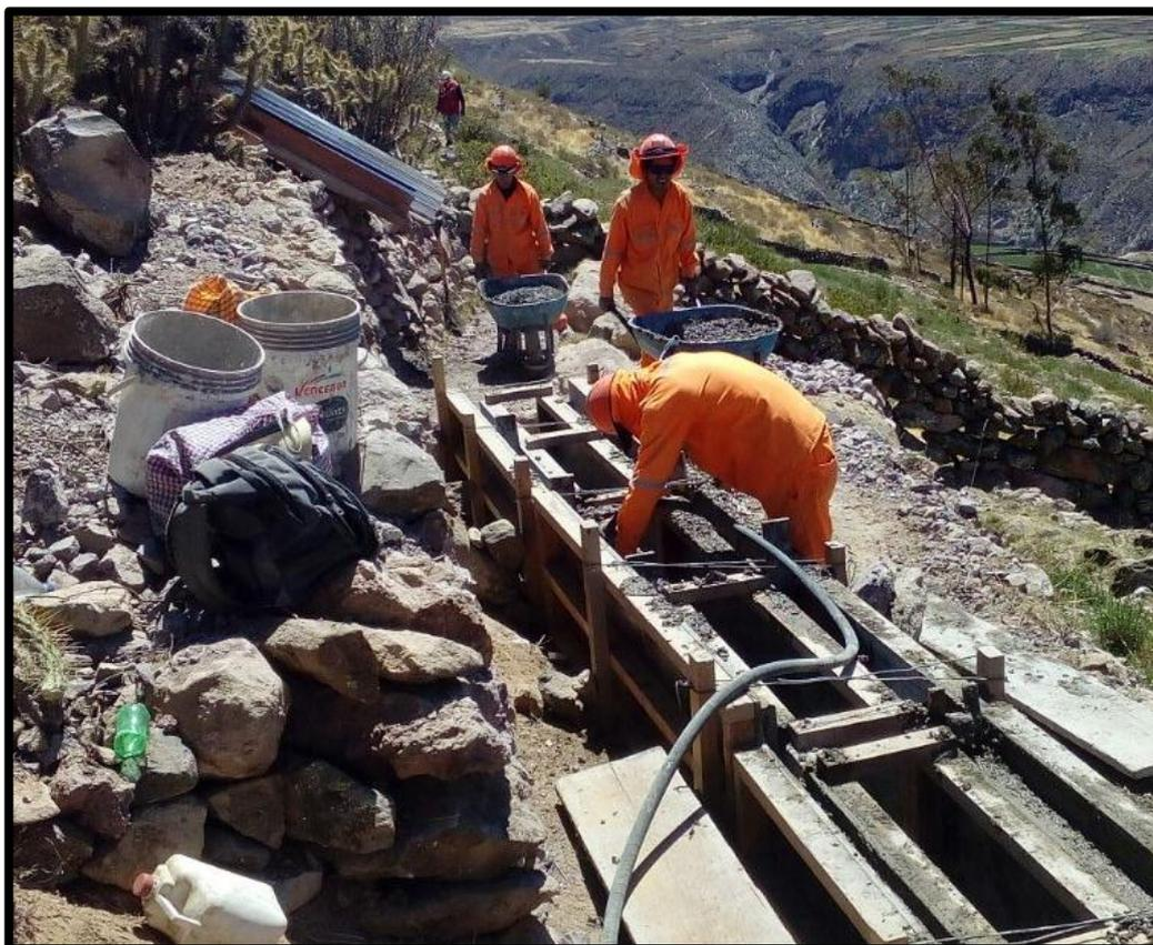
**Figura 34:** Vaciado de mezcla de concreto ladera.
