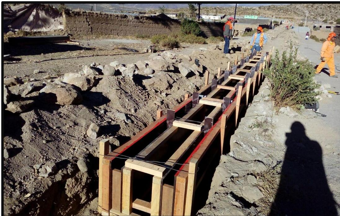
**Foto 3:** Encofrado del canal.
