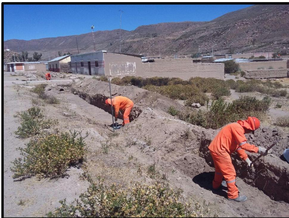
**Figura 22:** Excavación Manual del Terreno.
