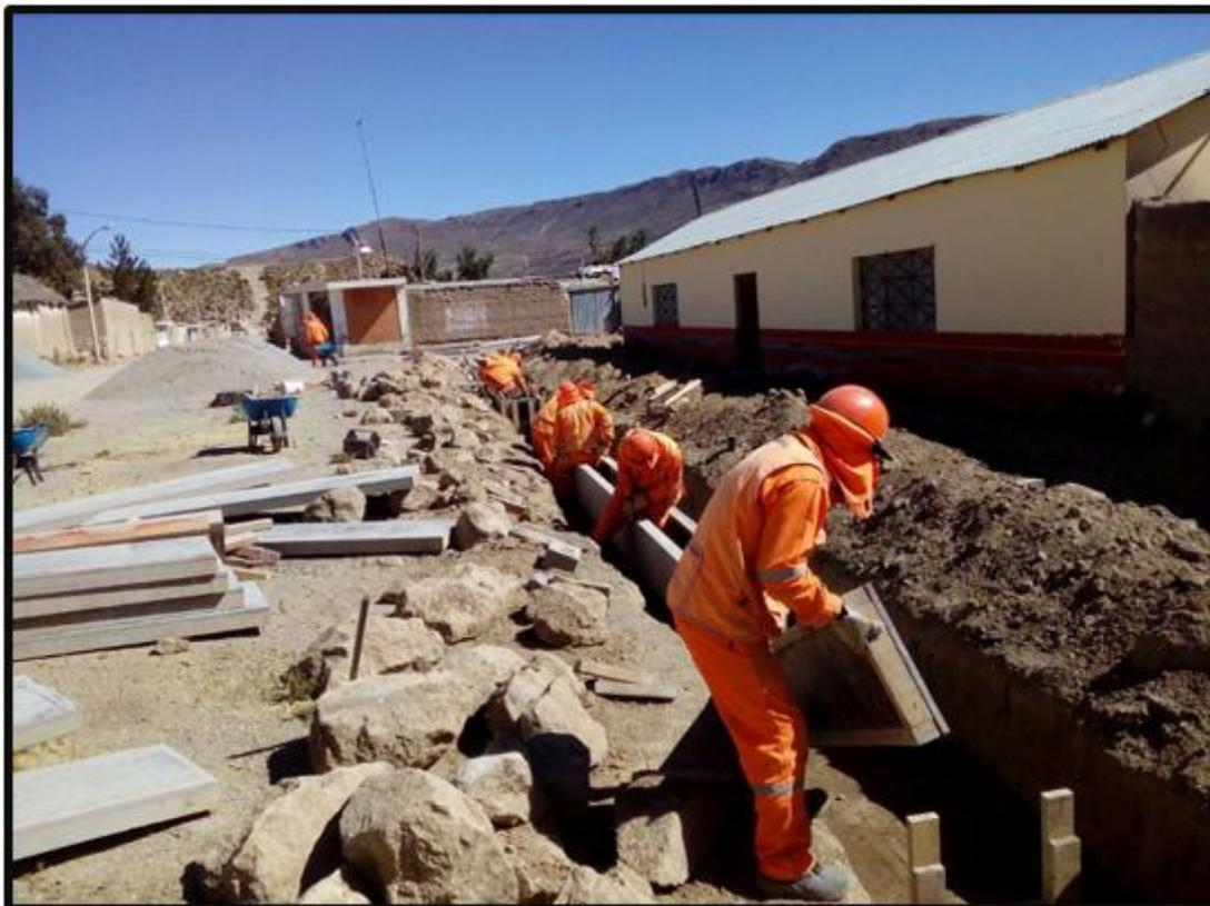
**Foto 5:** Desencofrado del canal.
