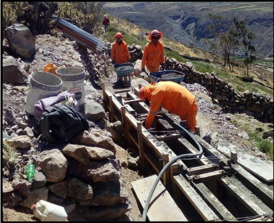
**Figura 30:** Vaciado de mezcla de concreto.
