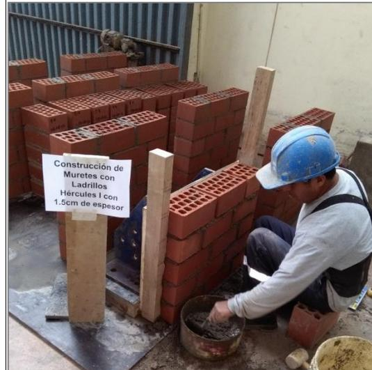
*Figura 2.2. Muretes con Ladrillos Hércules I con 1.5 cm de espesor*
