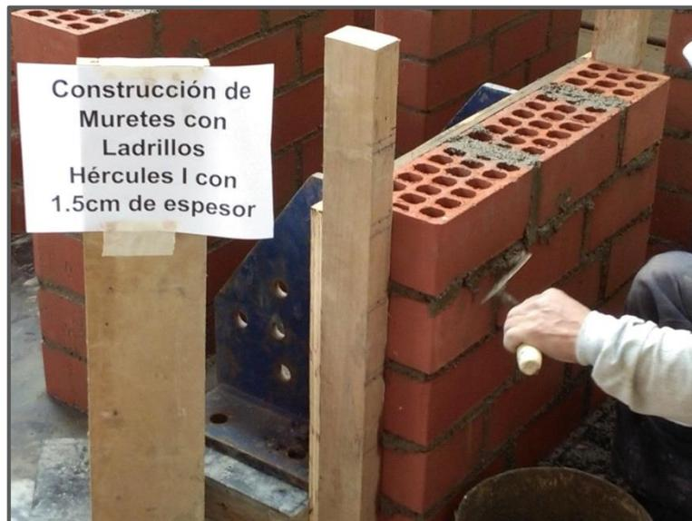
Fotografía N°05. Vista general del murete de ladrillos de arcilla Hércules I con un espesor de mortero igual a 1.5 cm.
