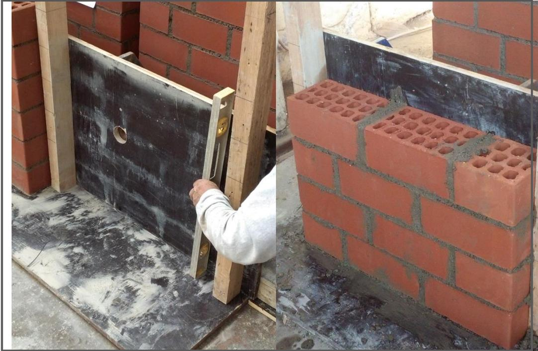
Fotografía N°04. Construcción de los muretes de ladrillos de arcilla Hércules I con un espesor de mortero igual a 1.5 cm, de izquierda a derecha:
