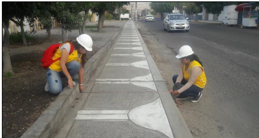
Foto 14: En la vista se observa la medición de la vereda perteneciente al acceso Noroeste.
