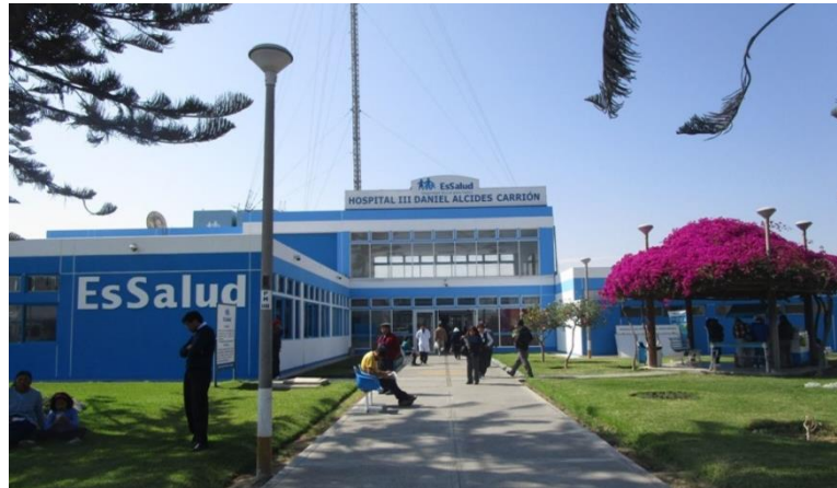
Figura 31: Fachada Principal EsSalud. Nota: Fuente: Diario Sin Fronteras.
