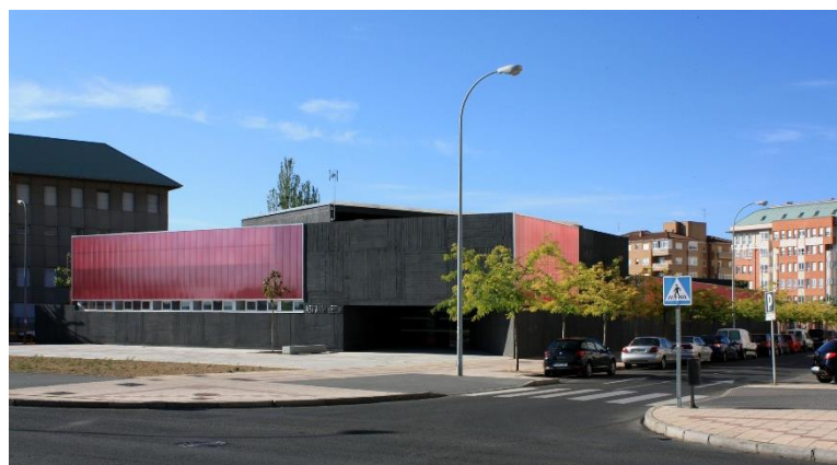
Figura 17: Fachada Sureste - Centro de día para personas con discapacidad 'ASPAYM'.
