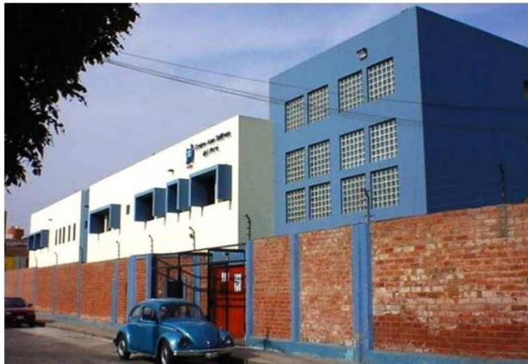
Figura 22: Fachada Principal - Centro Ann Sullivan. Nota: Fuente: José Bentín Arquitectos.
