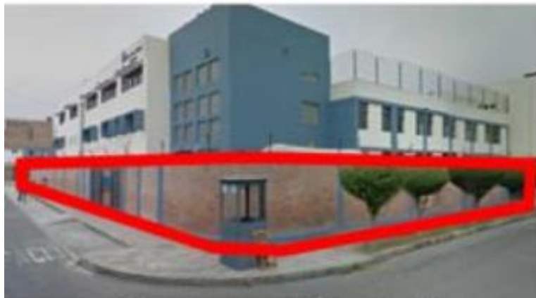
Figura 27: Muro Perimetral - Centro Ann Sullivan.
