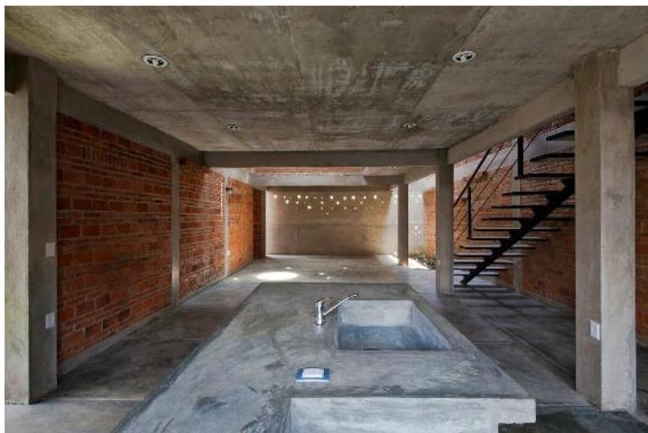
***Ilustración 79. Construcción de ladrillo y concreto***
