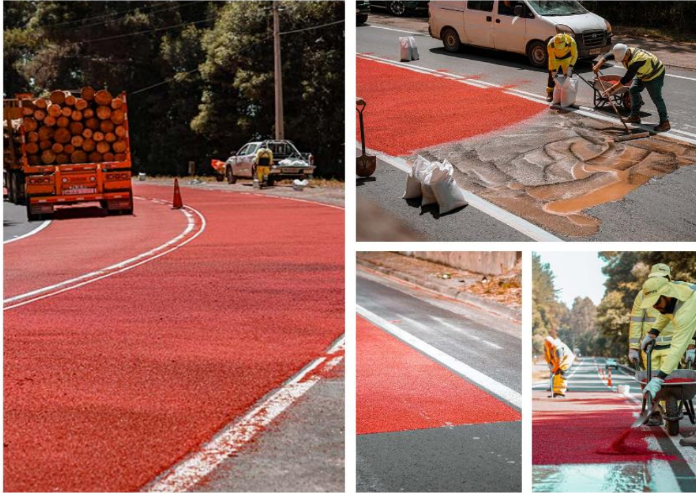
Figura 23 Aplicación de sello superficial de alta fricción
