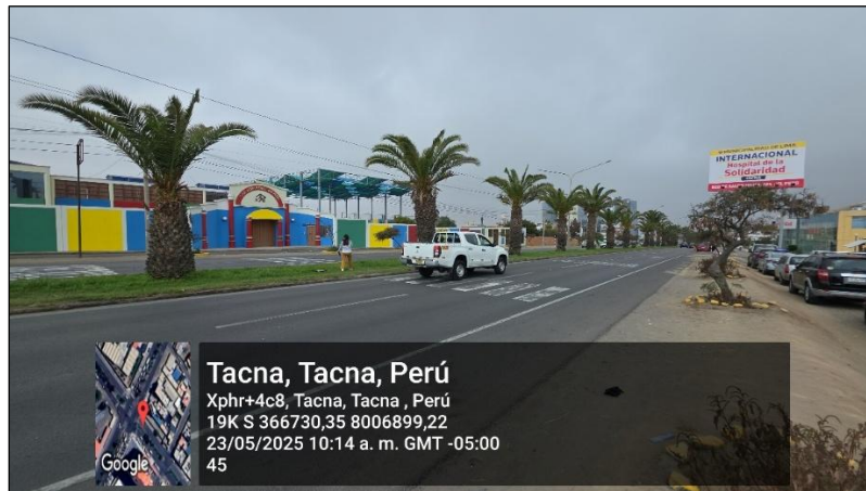
Fotografía 3. Cruce peatonal que intersecta la mediana central en la Av. Manuel A. Odría
