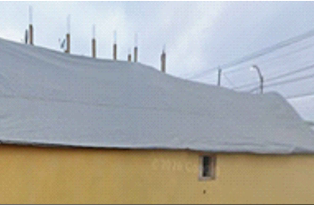
IMAGEN 03: Vista lateral del mojinete con lámina de polietileno
