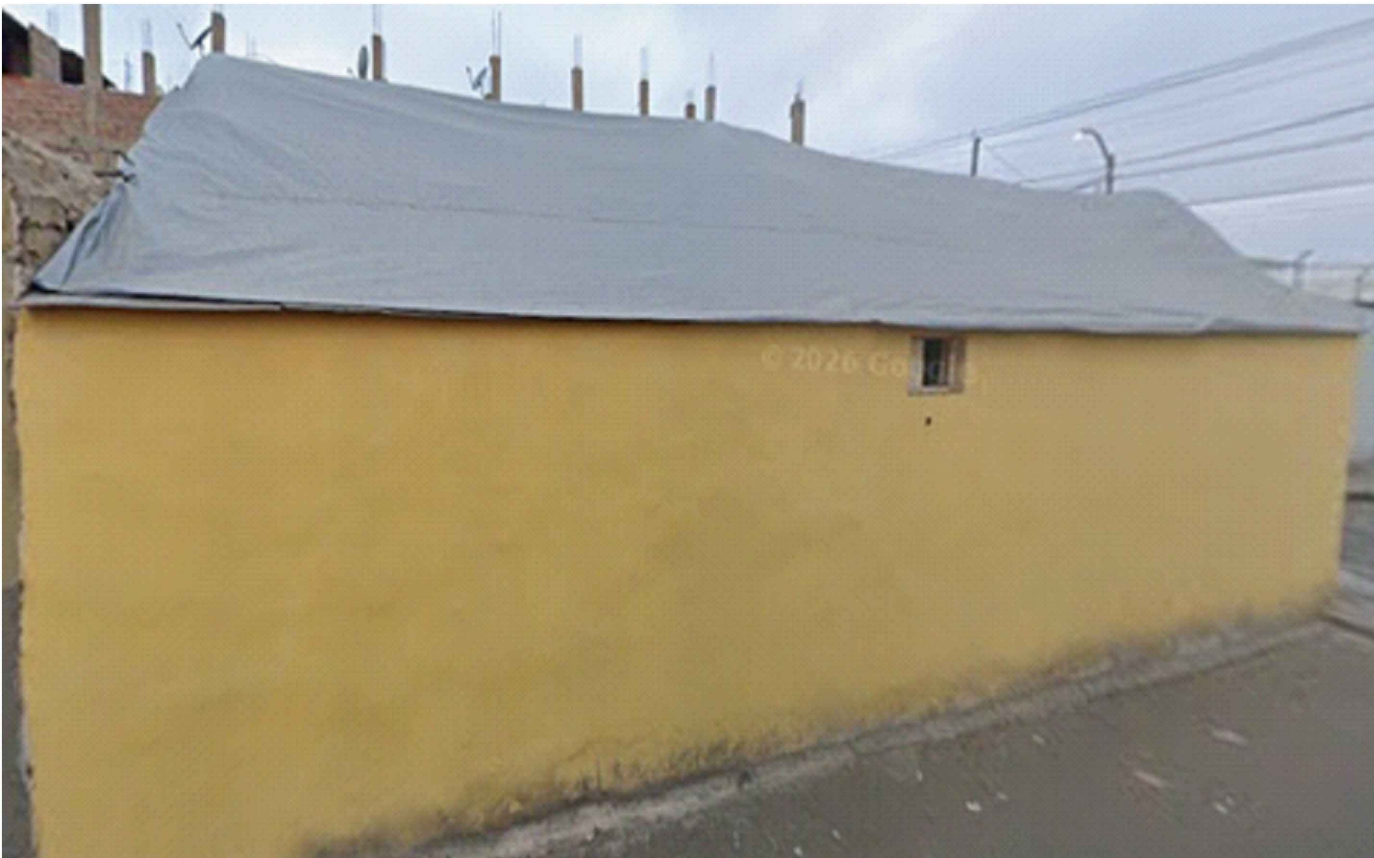
IMAGEN 02: Vista exterior de la fachada lateral de la vivienda
