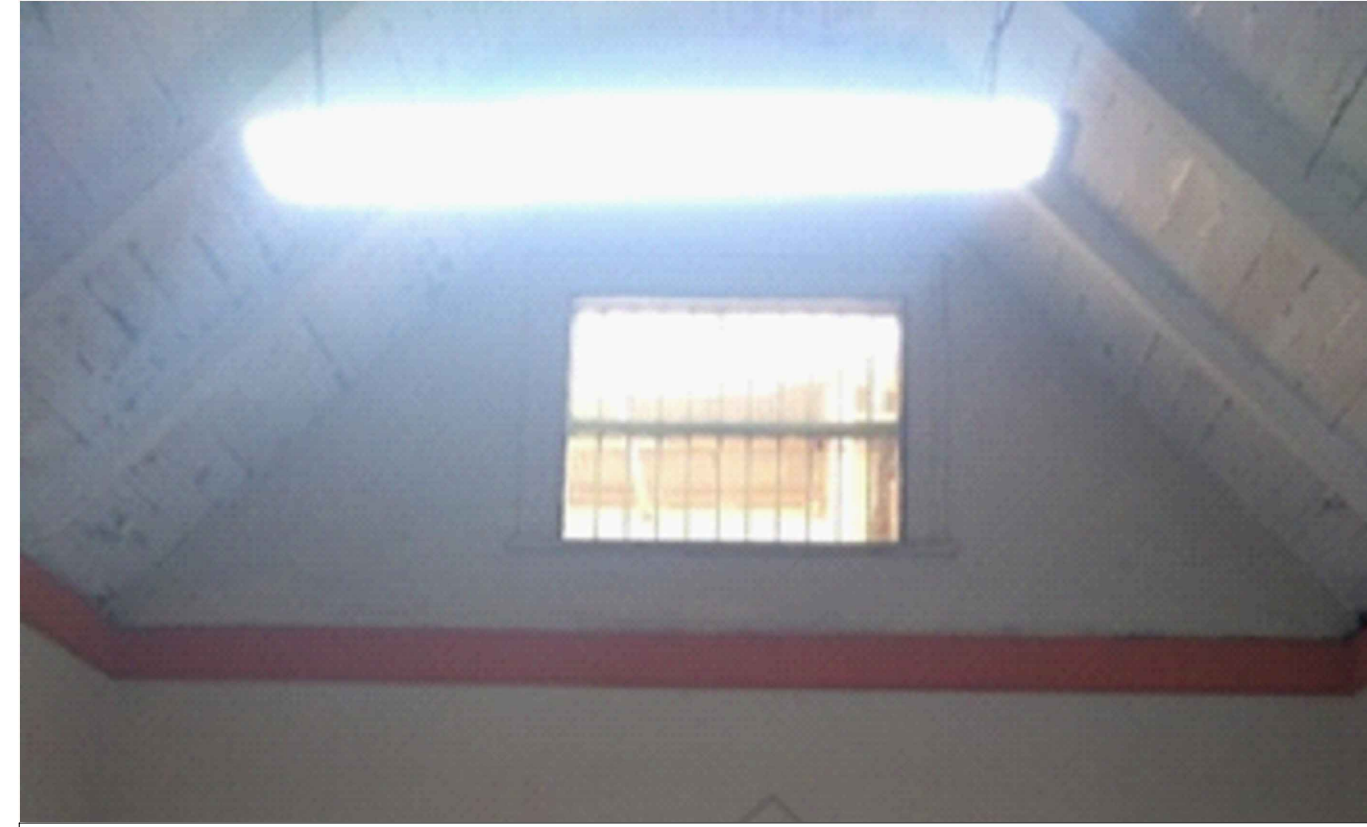
IMAGEN 03: Vista interior de la estructura de cobertura Mojinete
