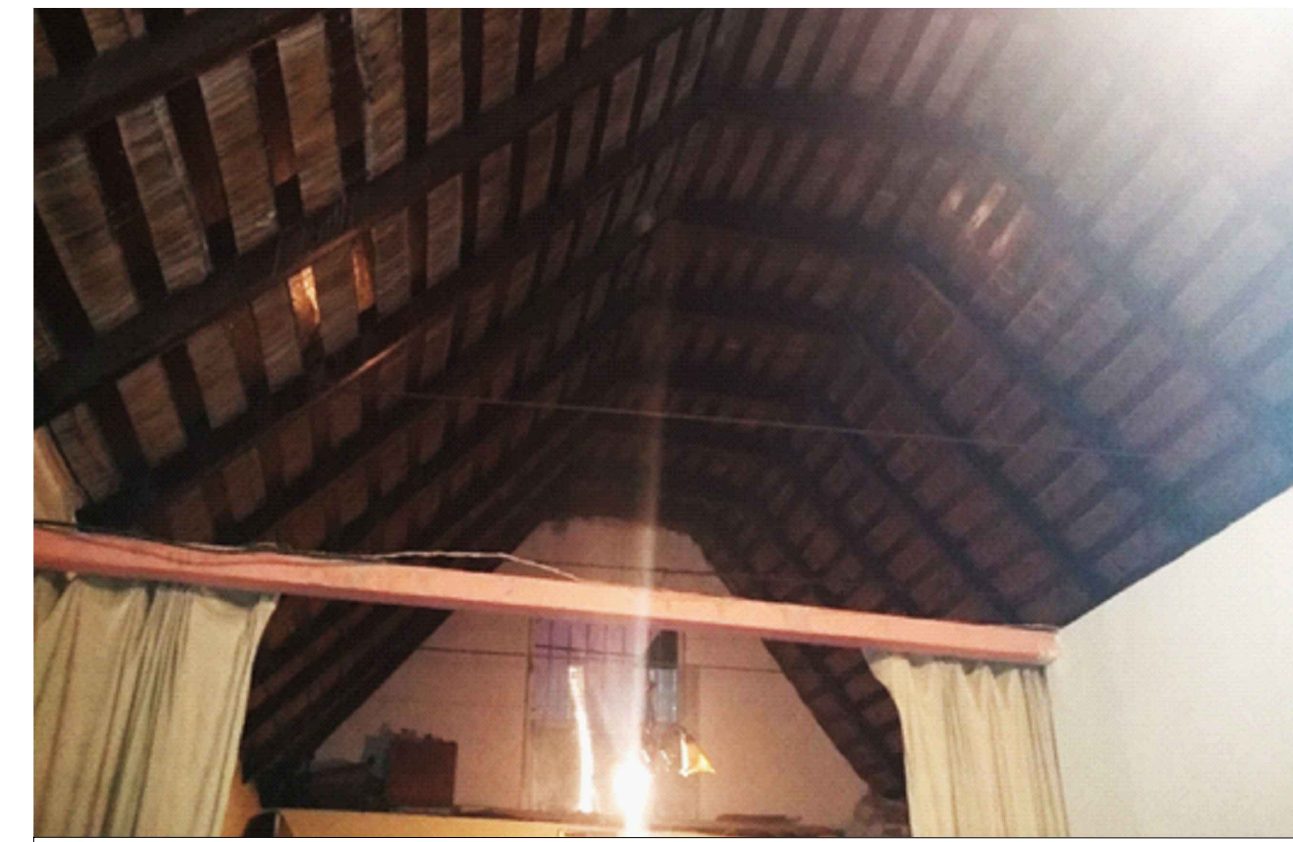
IMAGEN 04: Vista interior de estructura de cobertura mojinete
