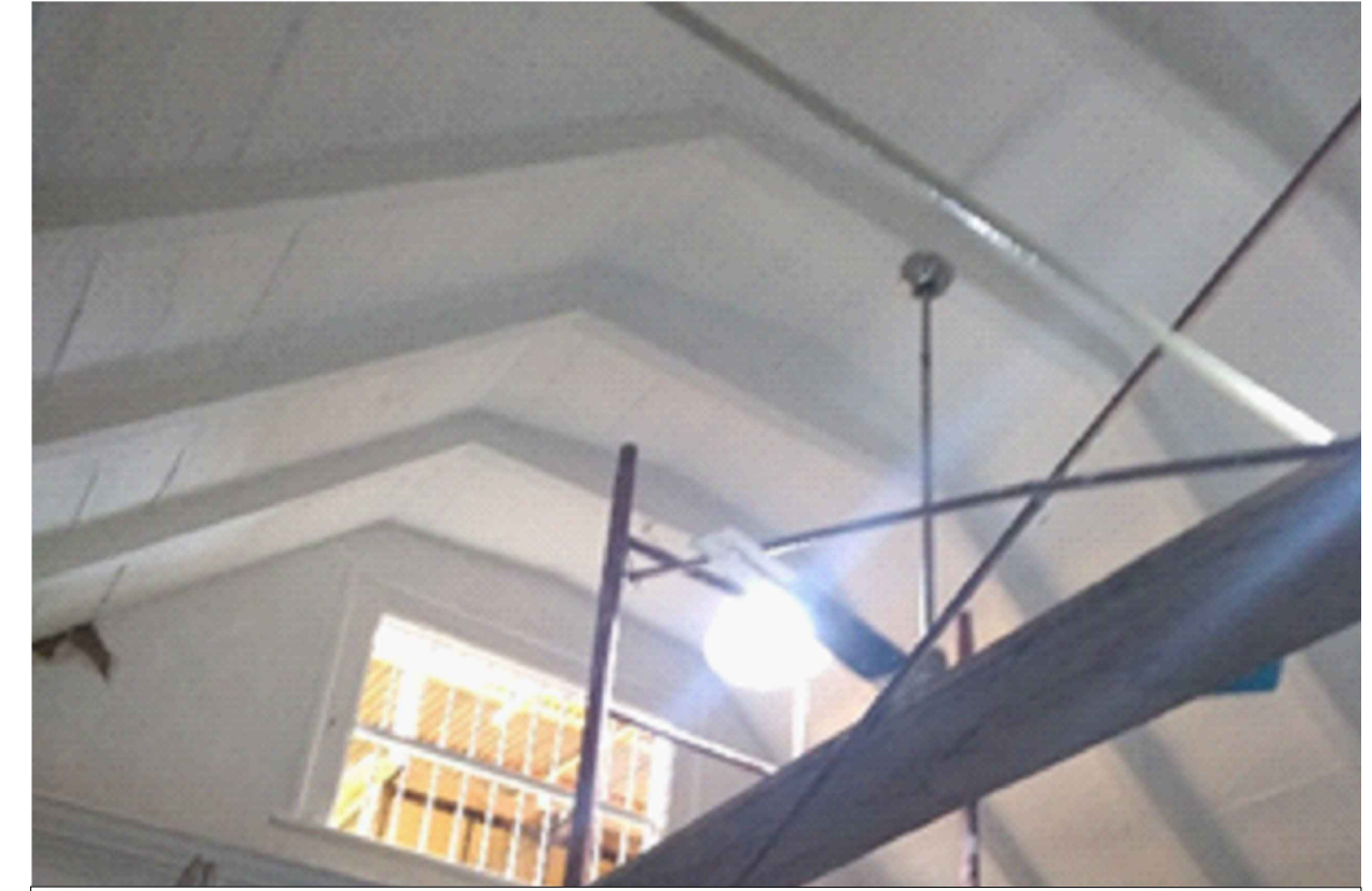
IMAGEN 04: Vista interior de la estructura de cobertura Mojinete
