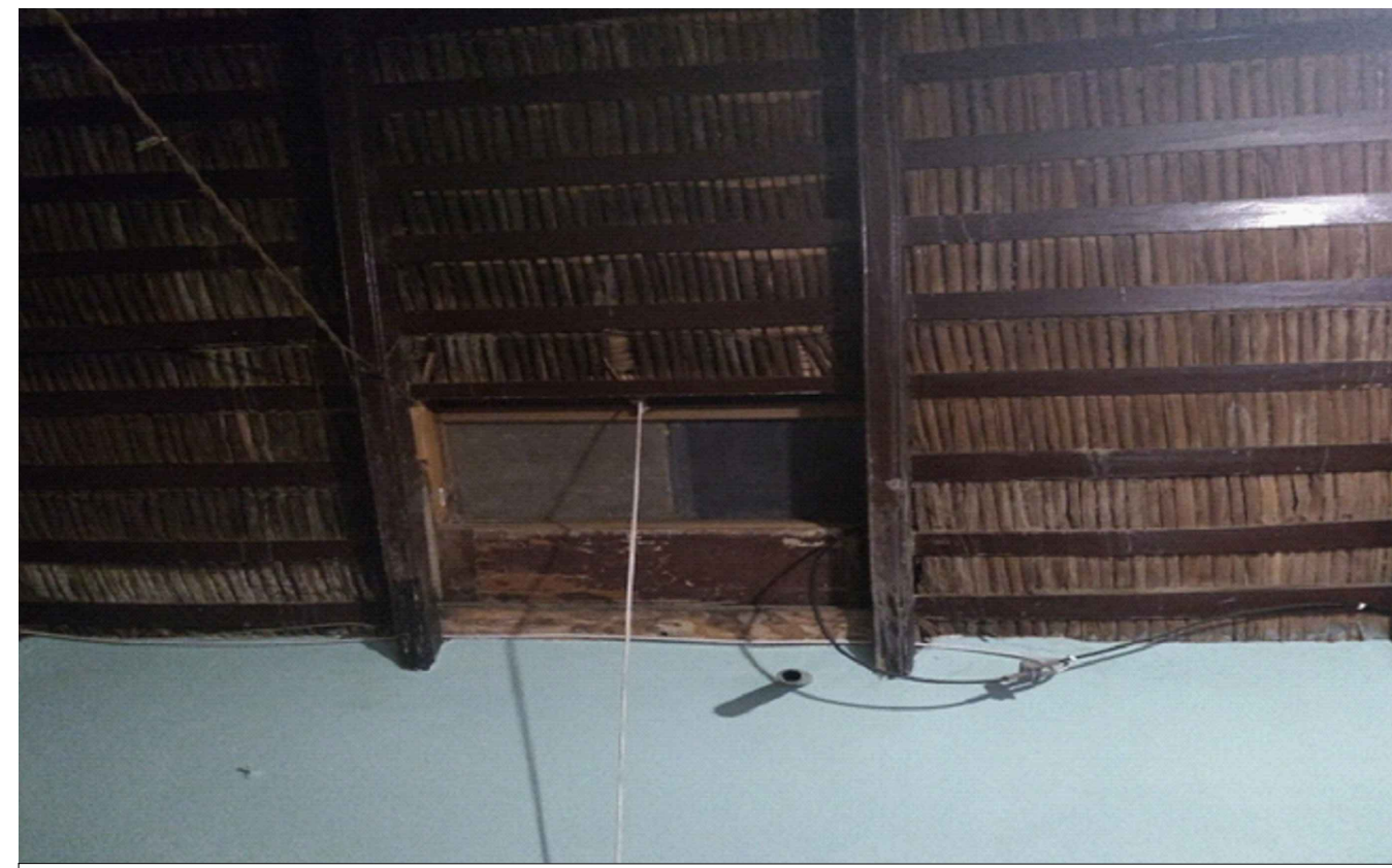
IMAGEN 02: Vista interior de estructura de cobertura mojinete
