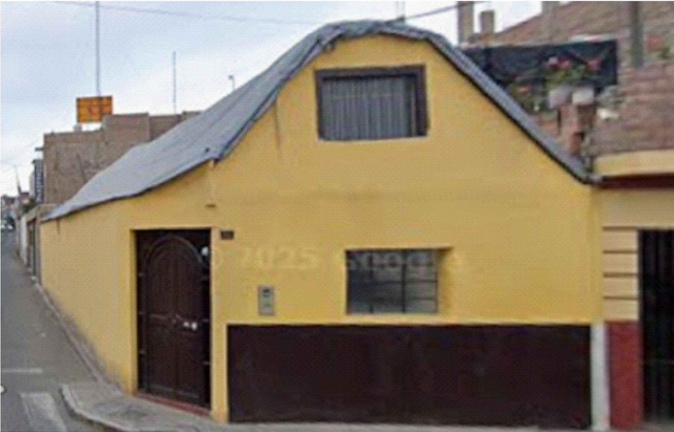
IMAGEN 03: Vista exterior de la fachada frontal de la vivienda
