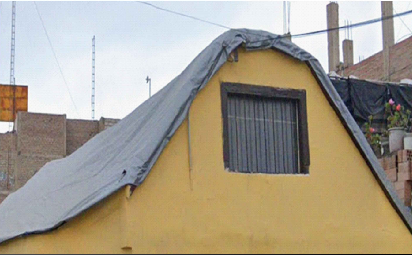
IMAGEN 02: Vista frontal del mojinete con lámina de polietileno
