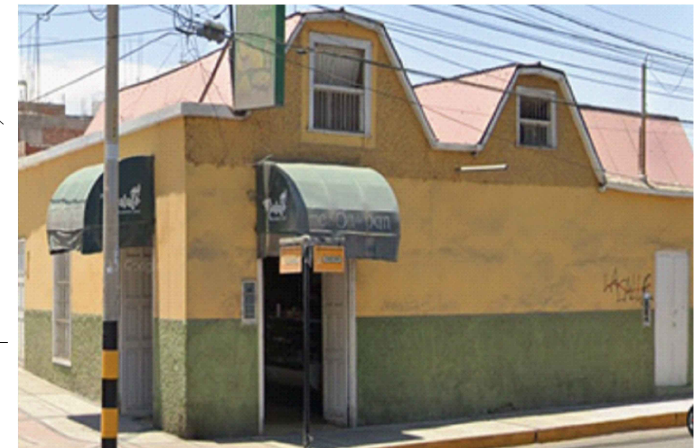
IMAGEN 01: Vista exterior esquina Basadre y Forero con Alto Lima
