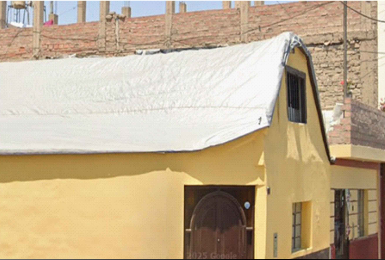
IMAGEN 04: Vista exterior de la cobertura mojinete
