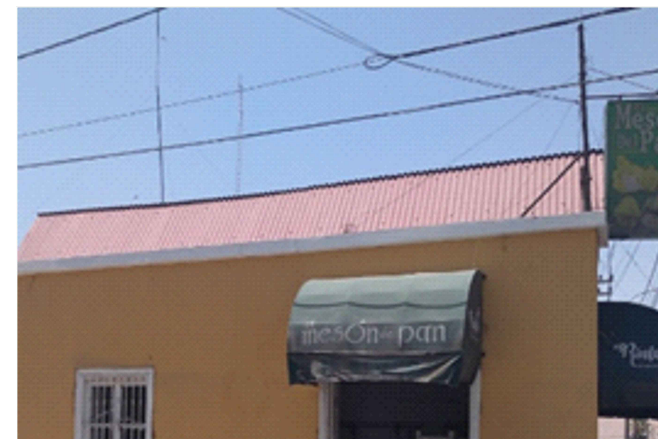
IMAGEN 03: Vista lateral de cobertura mojinete con calaminón galvanizado
