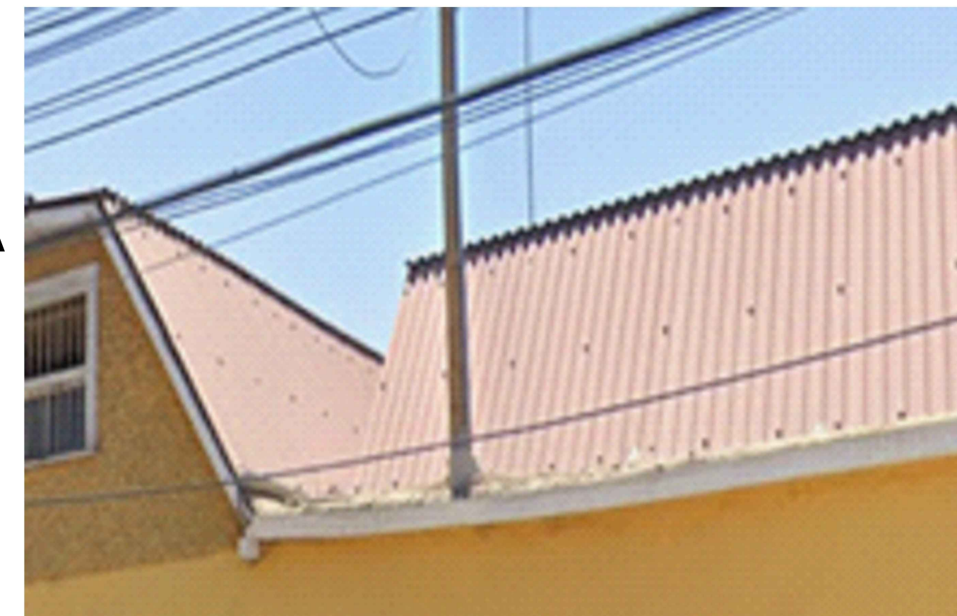
IMAGEN 02: Vista exterior frontal de la Vivienda Tipo Cuartos Agrupados
