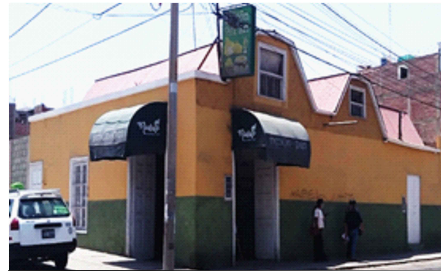
IMAGEN 02: Vista desde la esquina de la Av. Basadre y Forero con Alto Lima
