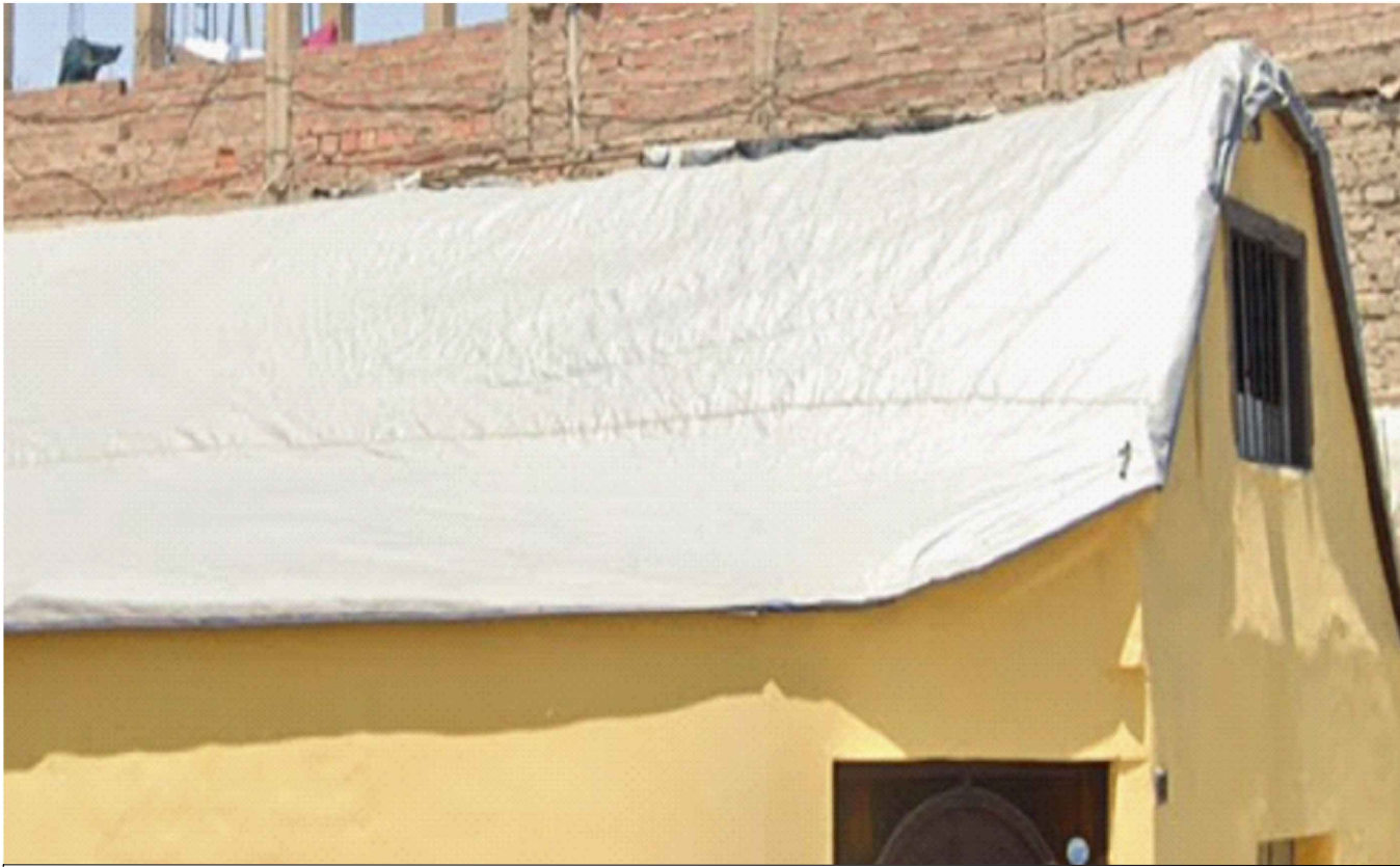
IMAGEN 01: Vista exterior de cobertura mojinete con lámina de polietileno
