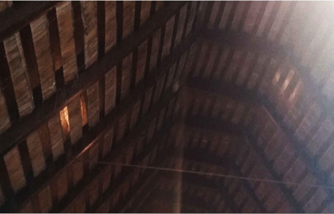
IMAGEN 04: Vista interior, estructura de cobertura mojinete
