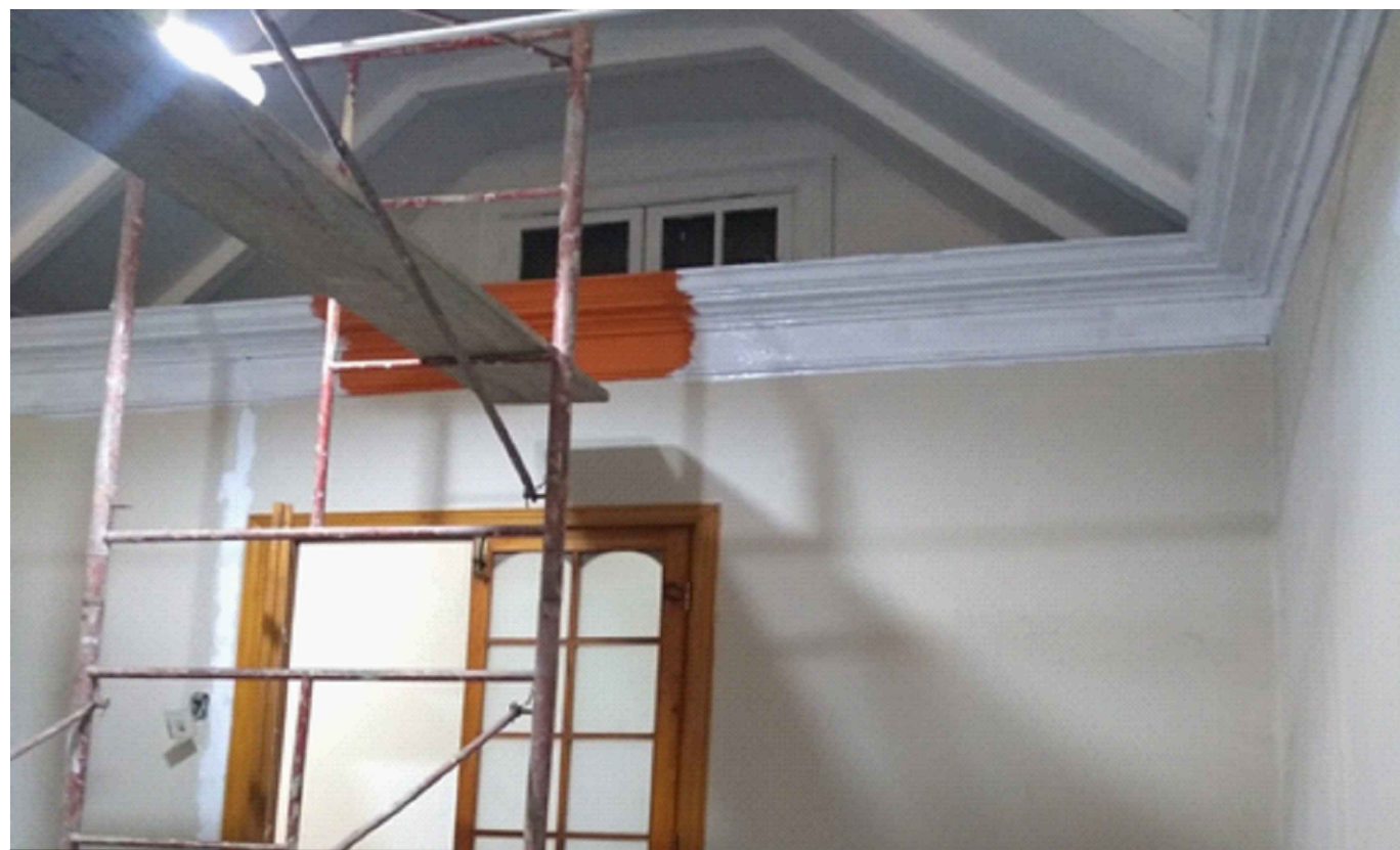
IMAGEN 02: Vista interior de de los muros y la cobertura Mojinete
