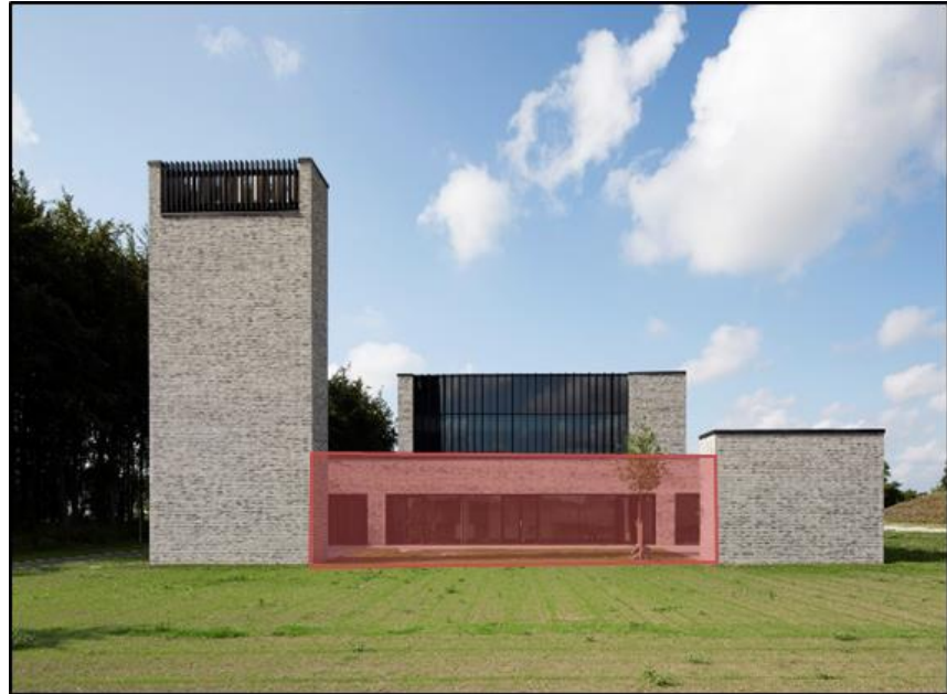
Figura 42: Fachada Principal del Crematorio
