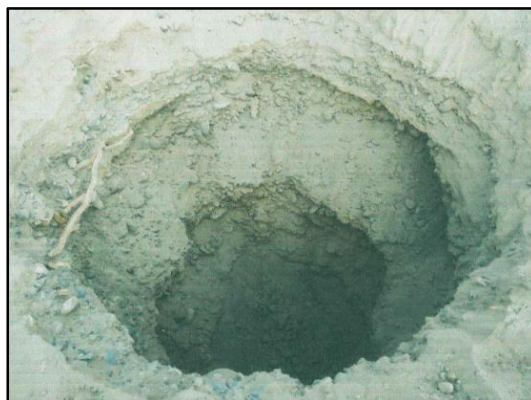
Figura 92: Calicata de Prueba
