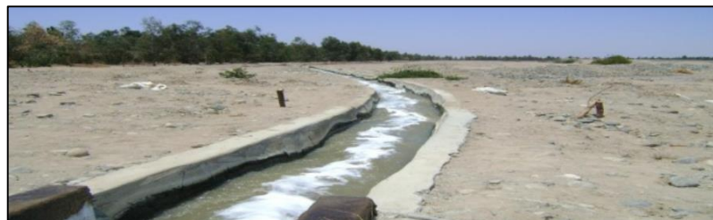
Figura 95 Canales del reservorio para aguas residuales
