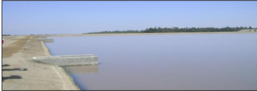
Figura 96: Reservorio de aguas residuales
