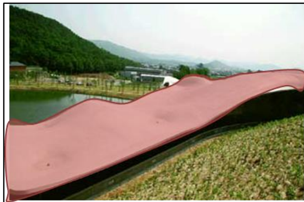
Figura 27: Imagen de la Cubierta del Crematorio
