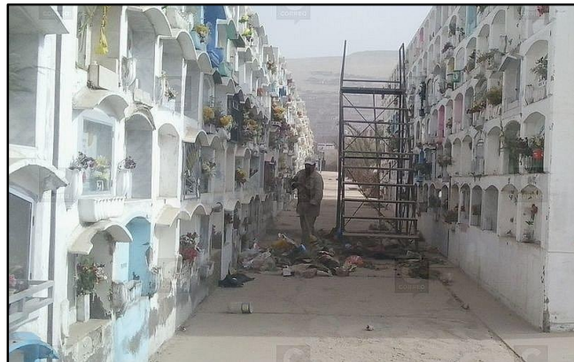
Figura 62: Nichos al interior del Cementerio General de Tacna
