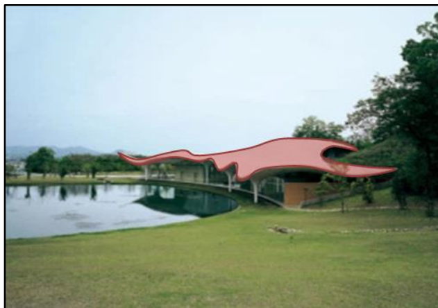
Figura 29: Vista de la Cubierta en el Crematorio
