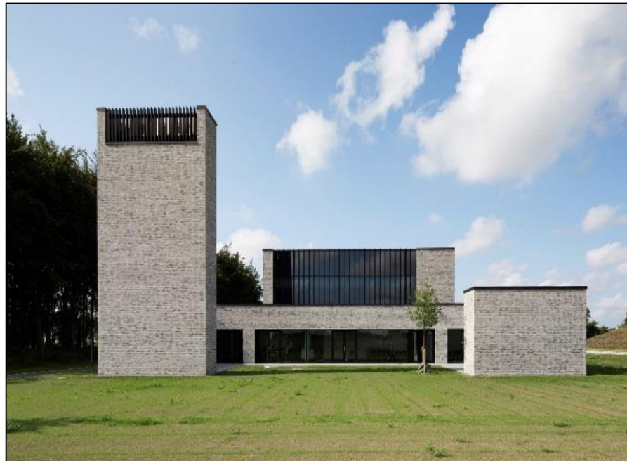
Figura 35: Fachada Principal del crematorio
