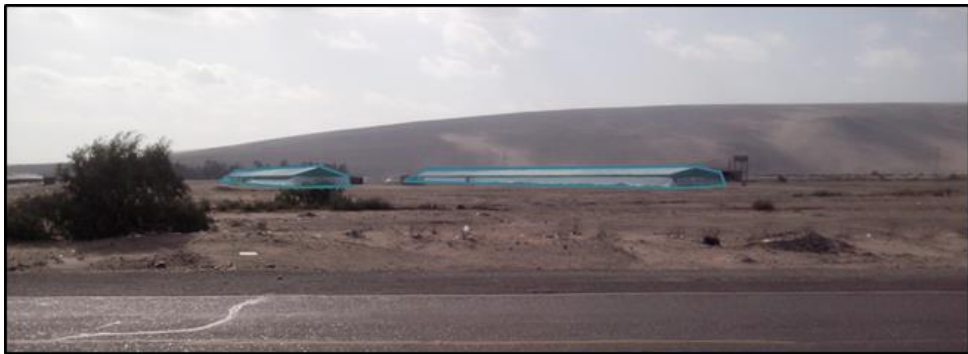
Figura 111: Construcciones Colindantes al Terreno
