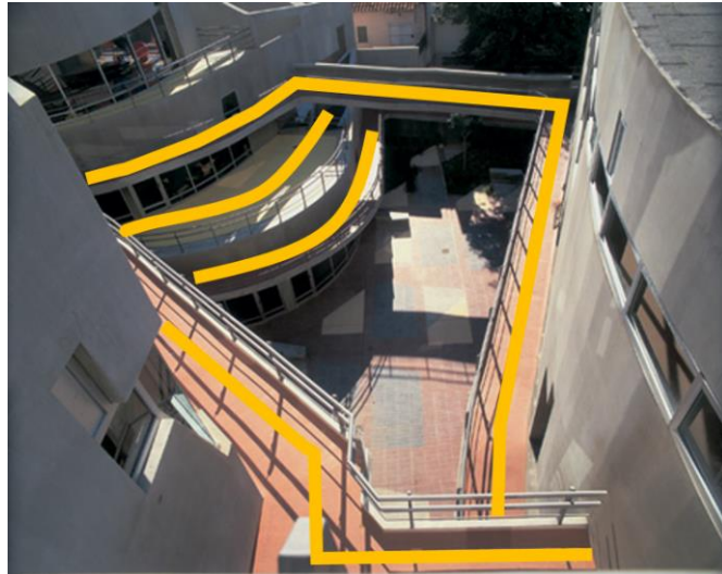
Figura 13: Vista 2 interior del instituto.
