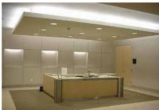
**Figura 115:** Falso cielo raso con iluminación indirecta.
