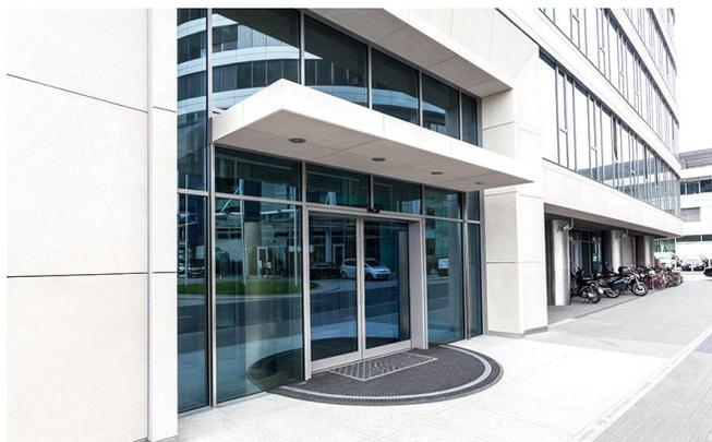
**Figura 114:** Fachada con muro cortina.
