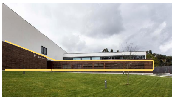
Figura 32. Materiales fachada interna del edificio residencial
