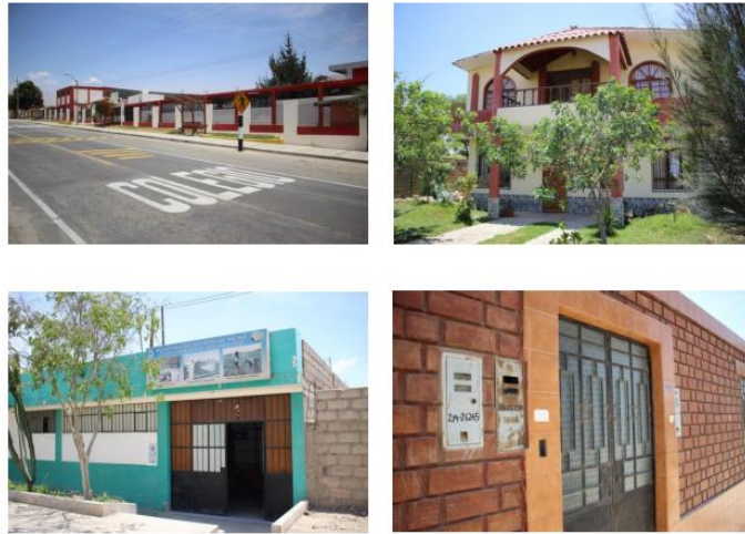
Figura 55. Materiales de construcción Nota: Fuente: Elaboración propia
