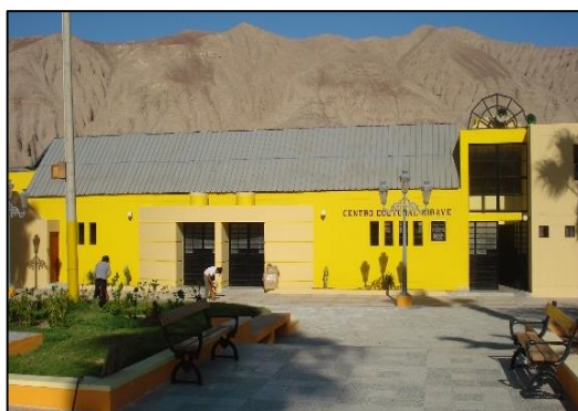
FIGURA N°19 CENTRO CULTURAL DE MIRAVE
