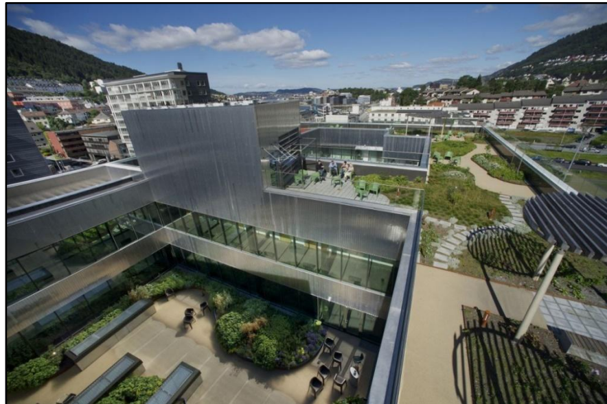
Figura 40. Galería de Hospital Psiquiátrico Kronstad / Origo Arkitektgruppe
