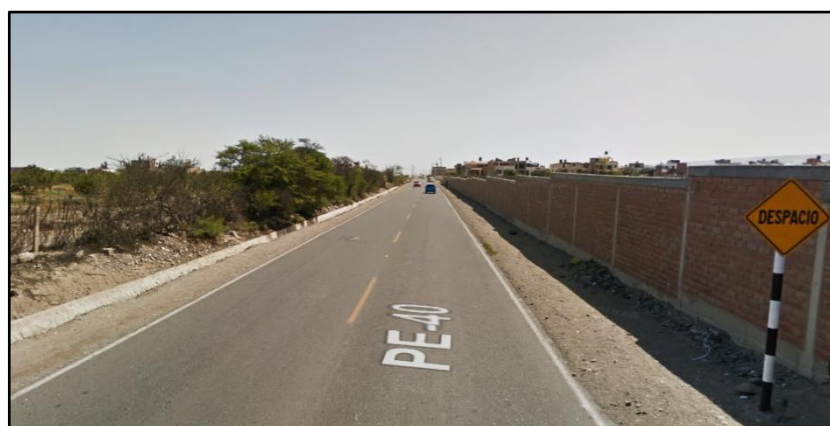
Figura 61. Estado de la vía de la Av. Tarapacá
