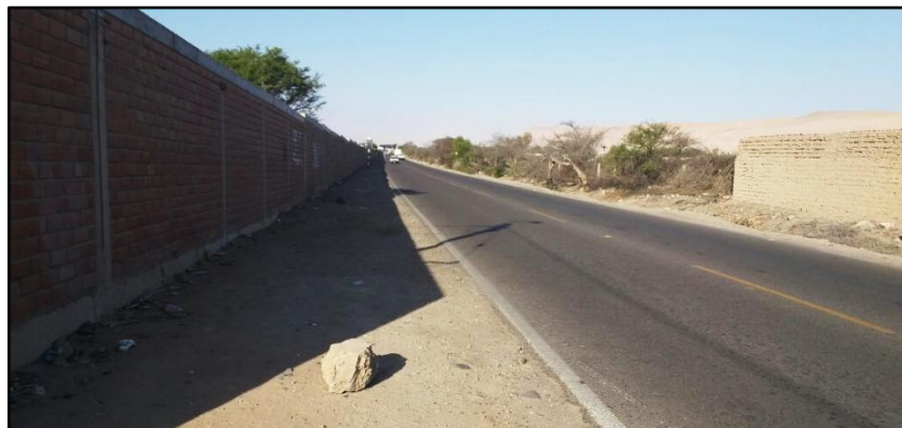
Figura 60. Vista de la Av. Tarapacá
