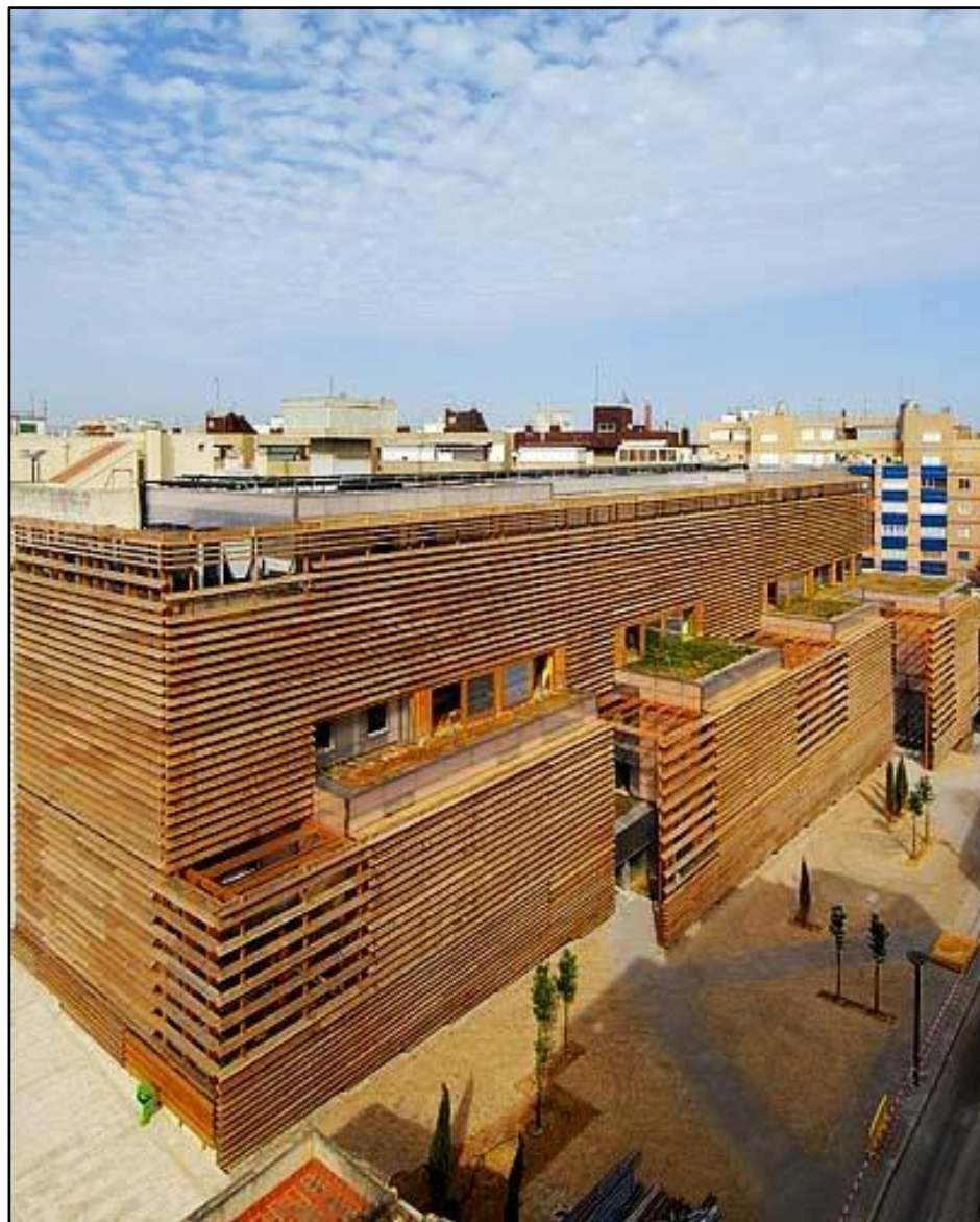
Figura 4. Vista aérea del Centro de Discapacitados Palma de Mallorca
