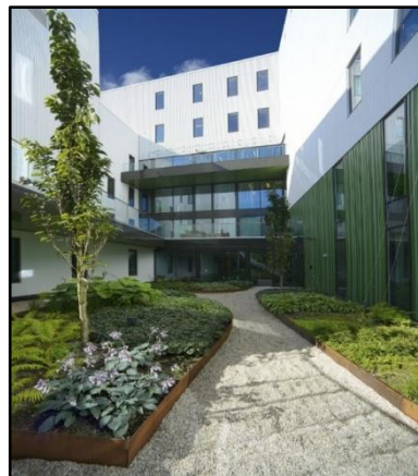
Figura 41. Galería de Hospital Psiquiátrico Kronstad / Origo Arkitektgruppe
