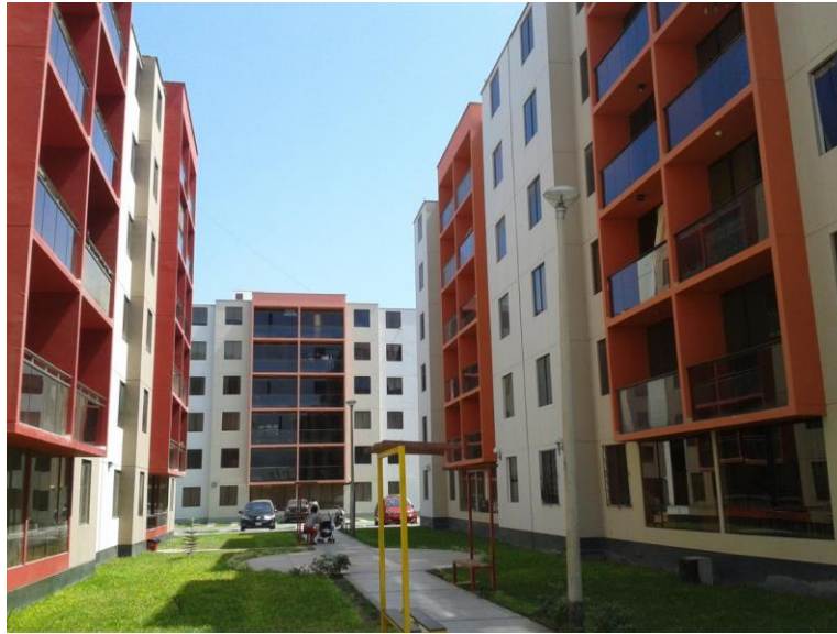
Foto 2.1 Edificaciones con muros de ductilidad limitada MDL en Chiclayo - Perú
