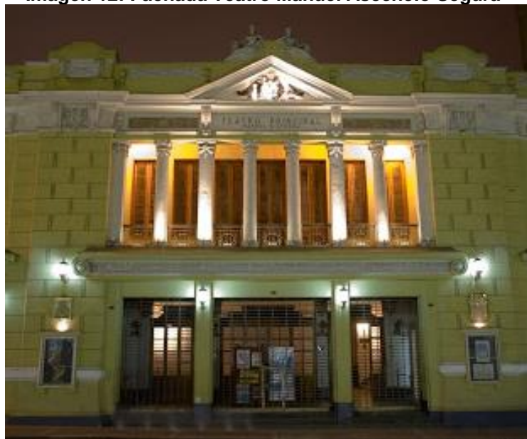
Imagen 12: Fachada Teatro Manuel Ascencio Segura
