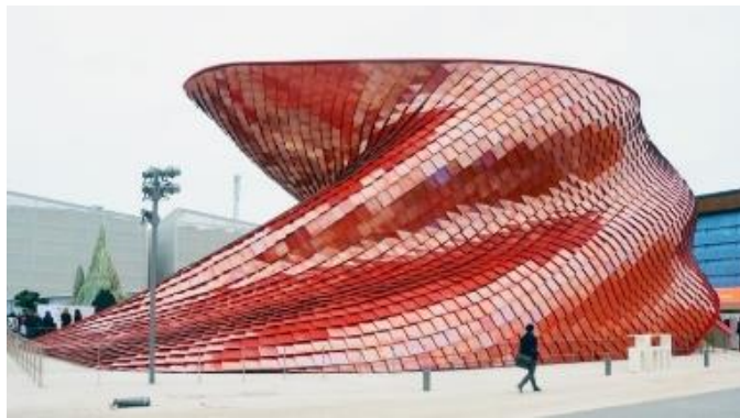
Imagen 43: recubrimiento con chapas metálicas sobre una estructura metálica
