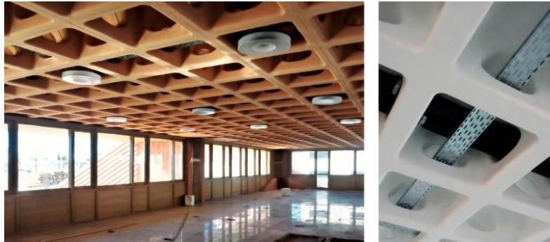
Imagen 44: Fotografías de losas nervadas
