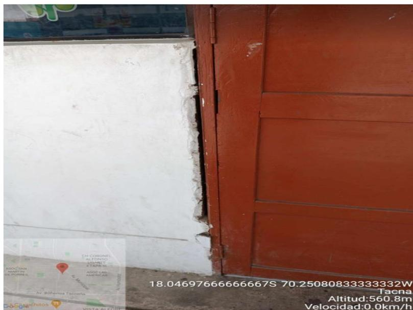
*Nota.* Se observa desprendimiento de concreto al costado de puerta.
