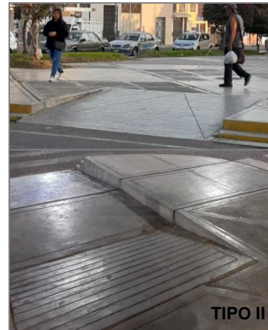
IMAGEN 04: Vista lateral de una rampa
