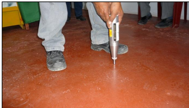
Figura 81. Ensayo de esclerometría de zona sana del piso.
