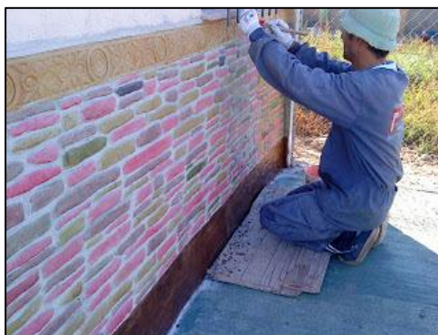
Figura 22. Zócalo de mortero
