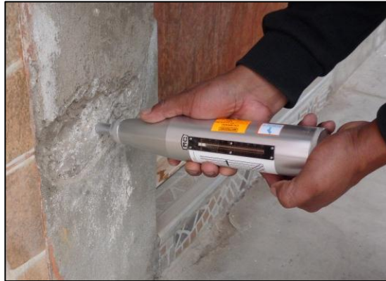
Figura 48. Ensayo de esclerometría
