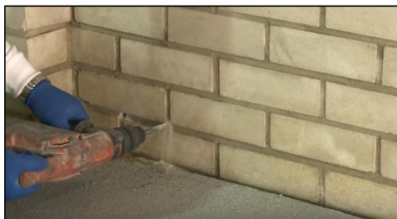
Figura 20. Procedimiento de inyección hidrófuga.
