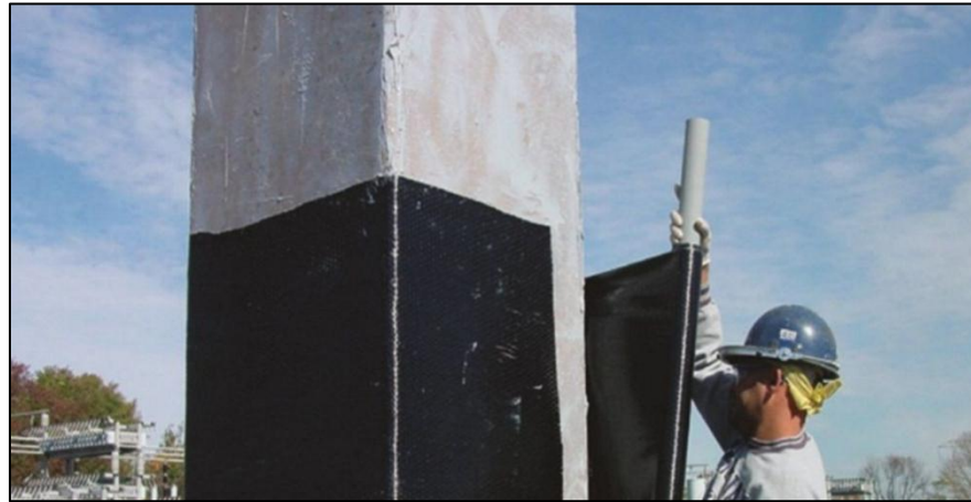
Figura 23. Reforzamiento de columnas con SikaWrap®-600C.
