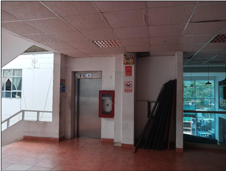
Fotografía 4: Interior de Palacio Municipal segundo piso
