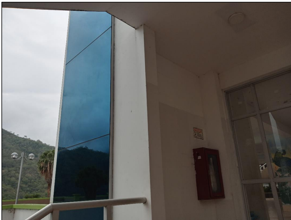
Fotografía 3: Interior de Palacio Municipal Caja de Ascensor
