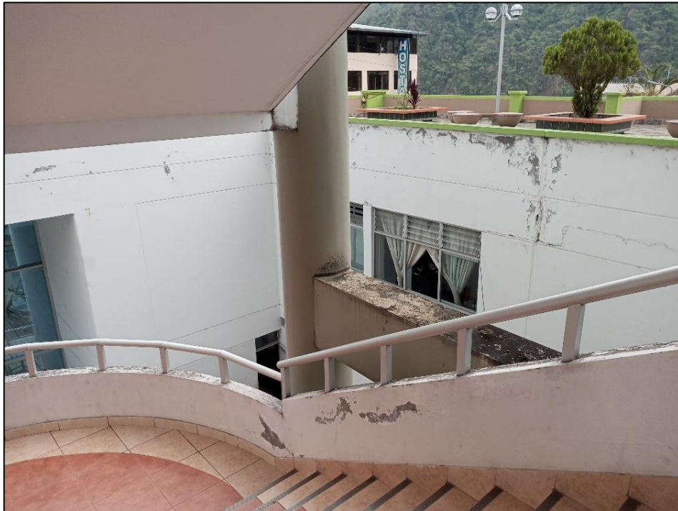
Fotografía 2: Interior de Palacio Municipal Caja de ascensor
