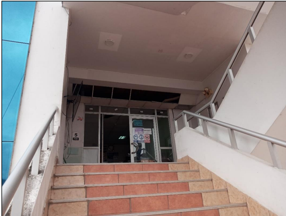
Fotografía 10: Interior de Palacio Municipal Vista de Terraza y volado de Tercer piso
