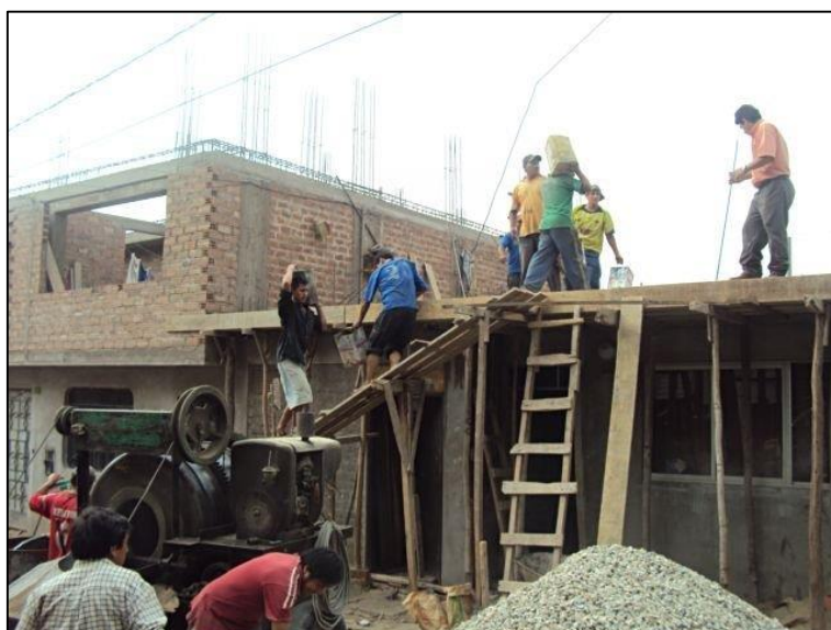
Figura - 01: Construcción de Vivienda en la Ciudad de Tacna
