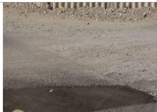
Fotografía N°20. Parcheo Progresiva Km 2+674,08-2+700
