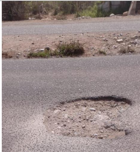
Fotografía N°17. Huevo Progresiva Km 2+228,40-2+265,54
