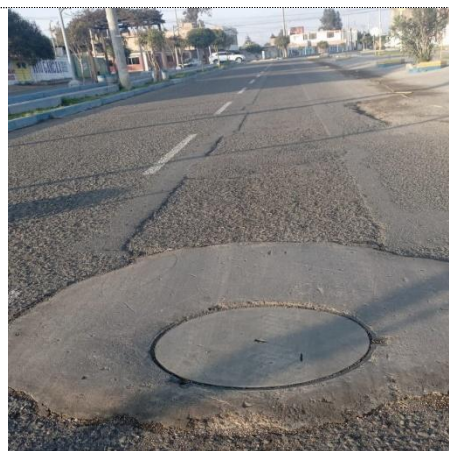
Fotografía N°02. Parcheo Progresiva Km 0+148,56 - 0+185,70
