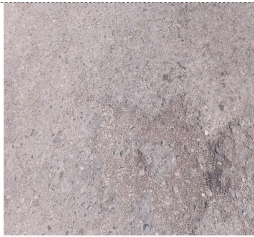
Fotografía N°06. Huevo Progresiva Km 0+631,38 - 0+668,52
