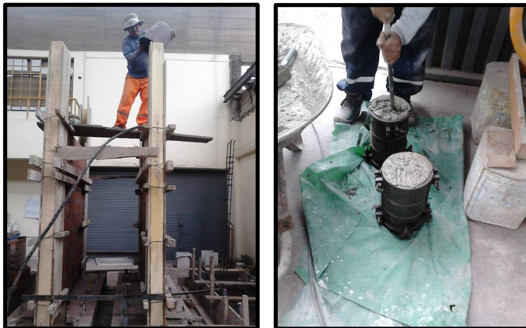
Foto 9 y 10. Vaciado de concreto en columnas y obtención de muestras.
