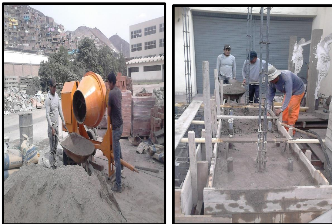
Foto 4 y 5. Preparación y vaciado de concreto F_c = 175 \text{ kg/cm}^2 en VC
