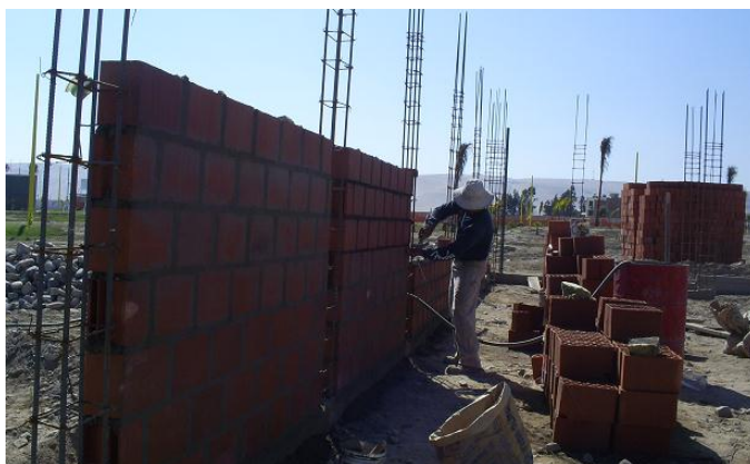
Foto 1. Vista del proceso constructivo del muro construido con Blocker II.
