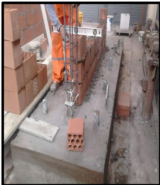
Foto 7 y 8. Asentado de ladrillos y verificación de verticalidad de muro
