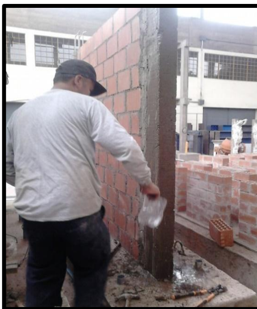
Foto 11. Curado de las columnas.
