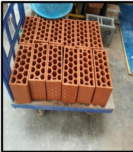
Foto 6. Preparación de unidades tipo Blocker II para el asentado
