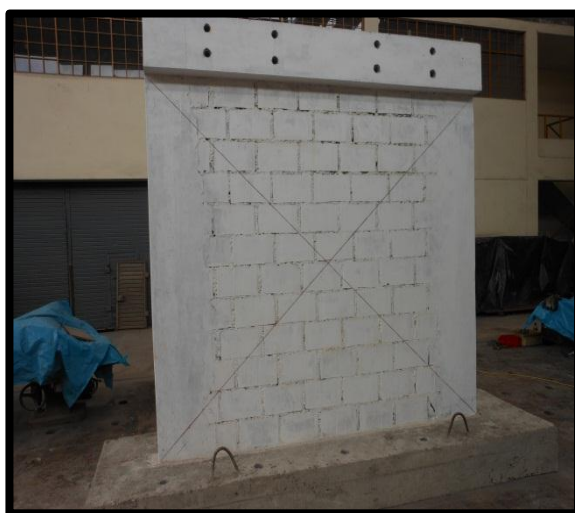
Foto 14. Construcción del muro M1 culminado apto para el ensayo
