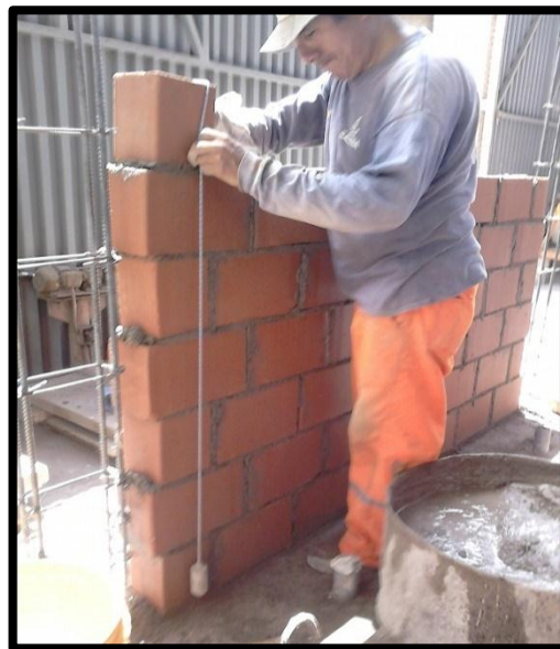
Foto 7 y 8. Asentado de ladrillos y verificación de verticalidad de muro
