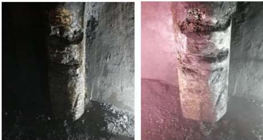
*Nota.* Se observa que la columna perdió mucho concreto y se aprecia el acero de refuerzo. *Fuente.* Foto, tomada el día de la inspección visual in situ.
