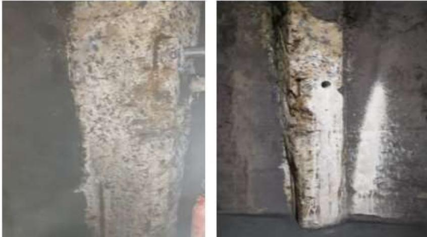
*Nota.* Se observa que perdió una considerable capa de concreto y se observa el acero de refuerzo. *Fuente.* Foto tomada el día de la inspección visual in situ.
