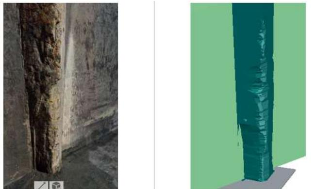
*Nota.* Se observa que la columna perdió mucho concreto y se aprecia el acero de refuerzo *Fuente*. Fotos tomado con el software RECAP
