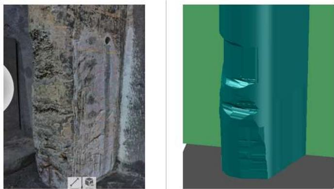
*Nota.* Se observa que la columna perdió mucho concreto y se aprecia el acero de refuerzo *Fuente.* Fotos tomado con el software RECAP.
