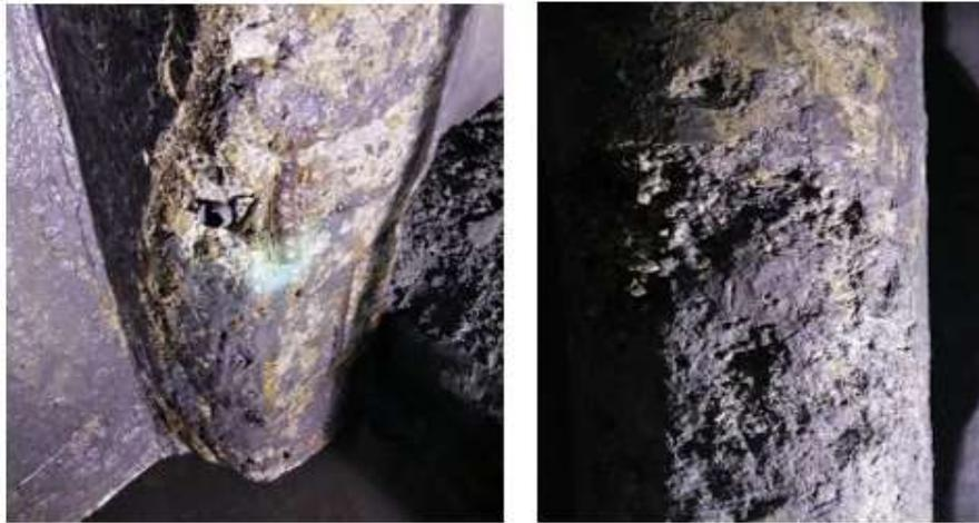
*Nota.* Se observa que perdió una considerable capa de concreto y se observa el acero de refuerzo. *Fuente.* Foto tomada el día de la inspección visual in situ.
