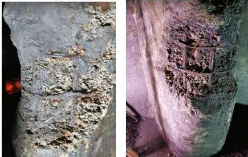
*Nota.* Se observa que perdió una considerable capa de concreto y se observa el acero de refuerzo. *Fuente.* Foto tomada el día de la inspección visual in situ.
