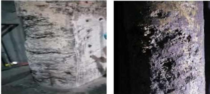
*Nota.* Se observa que perdió una considerable capa de concreto y se observa el acero de refuerzo *Fuente*. Foto tomada el día de la inspección visual in situ.
