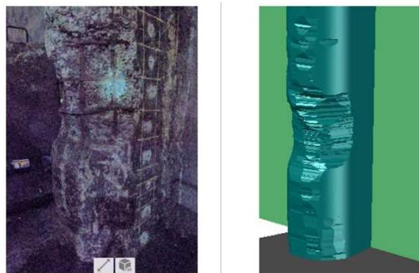
*Nota.* Se observa que la columna perdió mucho concreto y se aprecia el acero de refuerzo *Fuente.* Fotos tomado con el software RECAP.
