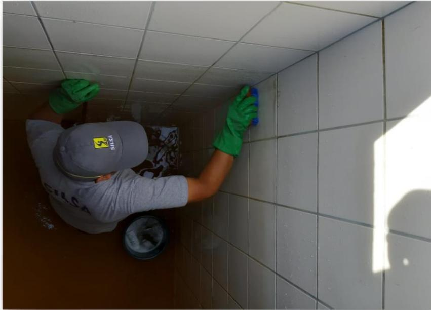
Imagen N° 31: Limpieza del Tanque Elevado de agua
