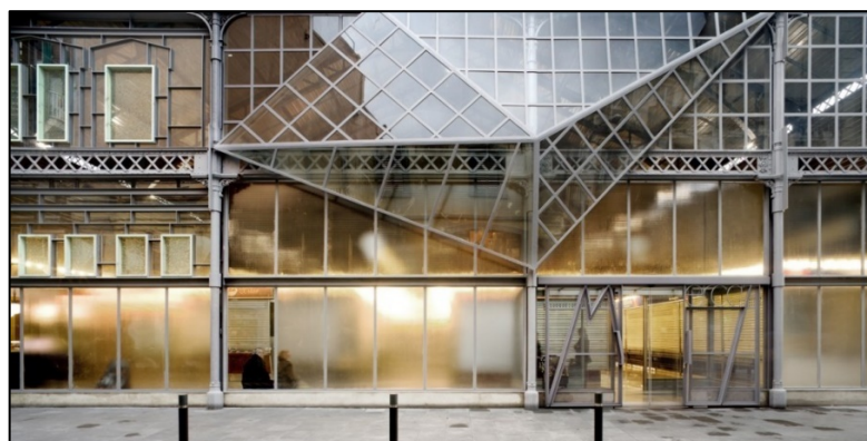
Figura 5. Estructura metálica y paneles de vidrio -vista exterior
