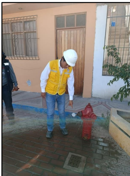
Fotografía N° 2: Presión de grifo en zona alta
