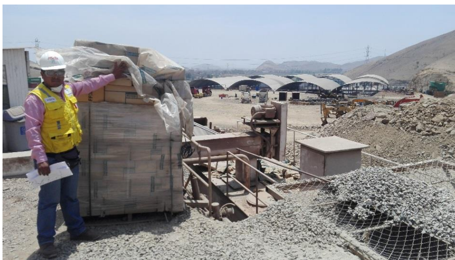
Logisminsa, almacenamiento de minerales para su carga.
