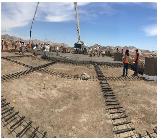
Durante la Obra
