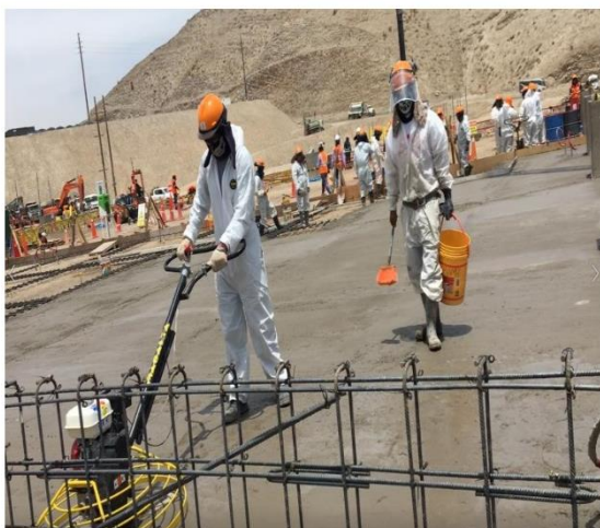
Durante la Obra
