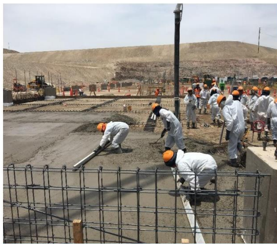
Durante la Obra
