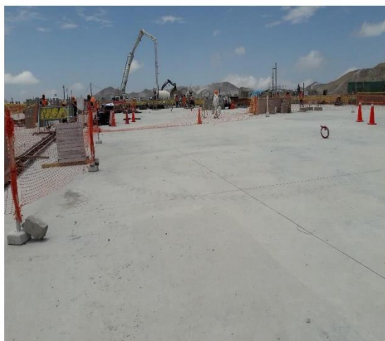
Durante la Obra
