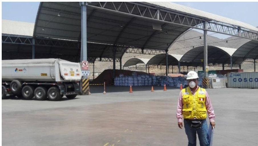
Almacén de minerales Logismminsá – Presencia de cargas
