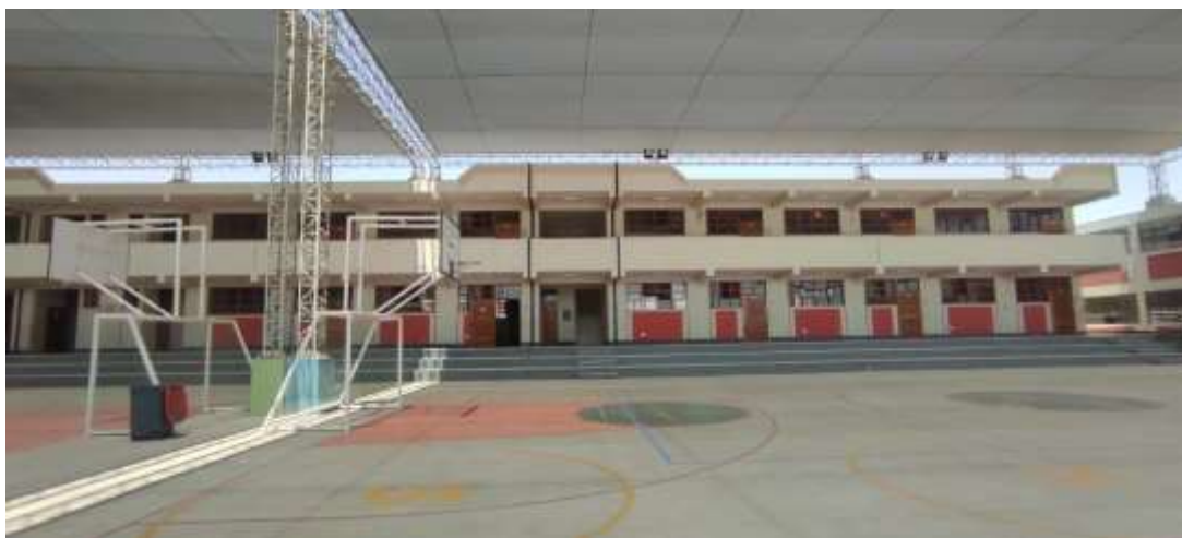
Figura 7. Vista general del bloque evaluado
