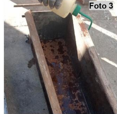
Foto 8,9: Desmoldaje de viga de concreto.
