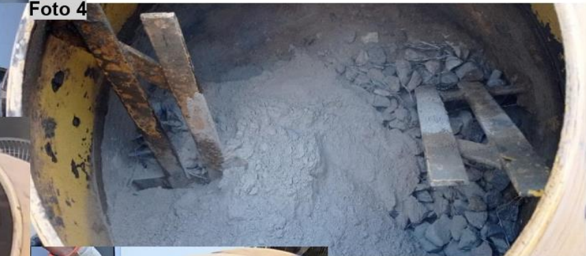
Foto 4: Se añade el cemento y se mezcla.
