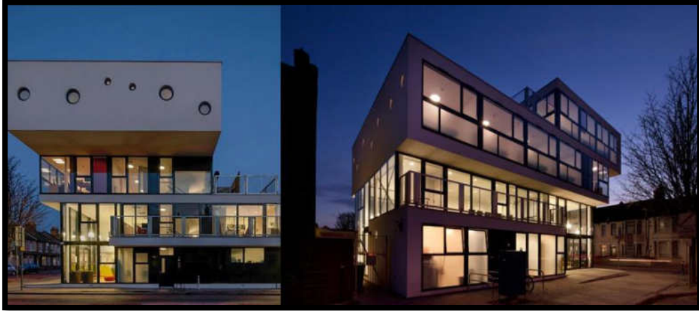
Figura 36 vista exterior fachada (centro Redbridge – Inglaterra)
