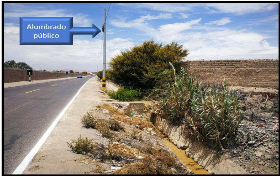
Figura 89 servicio alumbrado público, electricidad, elaboración propia.
