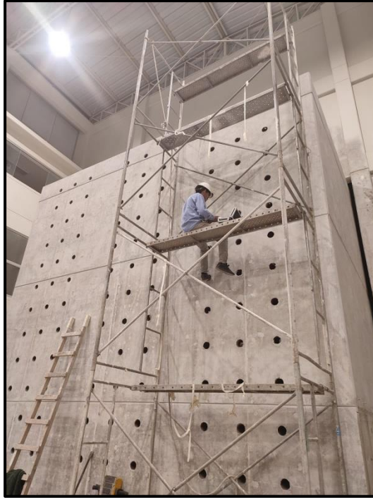
Fotografía 9. Se realiza nuevamente los ensayos con el esclerómetro en el tercer tramo del Muro de Reacción para los periodos de 14, 21 y 28 días.
