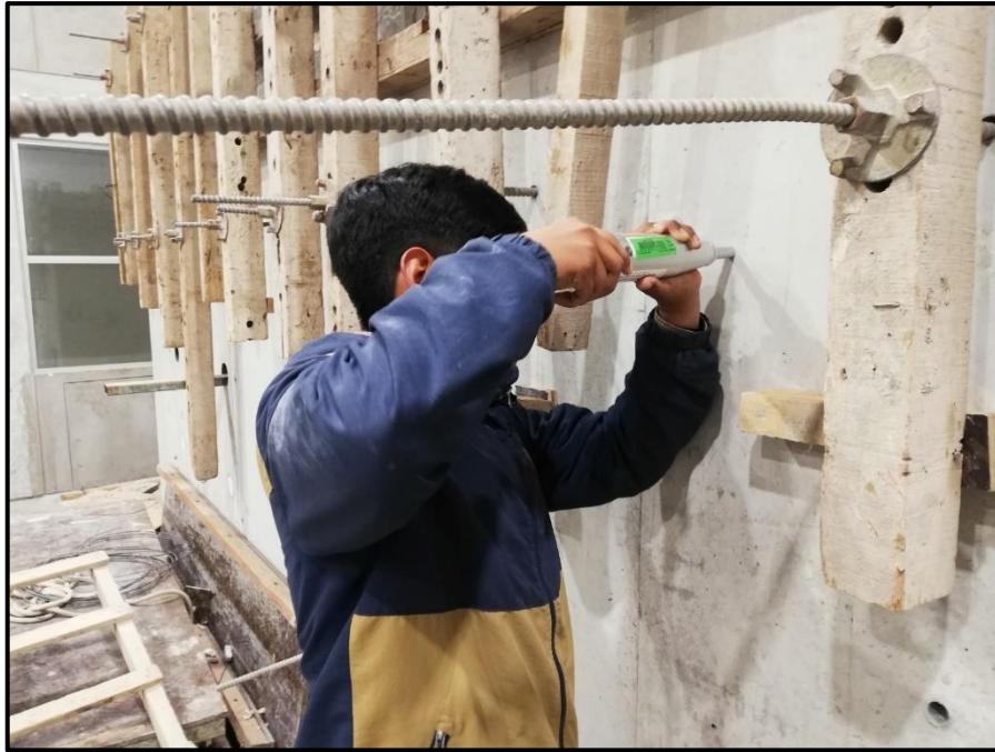
Fotografía 14. Uso de esclerómetro sobre la estructura a ensayar.
