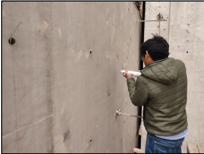
Fotografía 16. Procedimiento de ensayo en otra área de la estructura.
