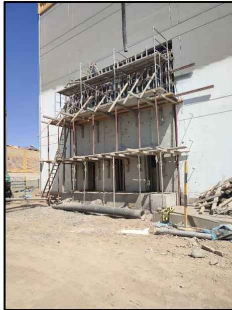
Fotografía 1. La estructura para evaluar corresponde al tercer tramo del Muro de Reacción, en la imagen se observa el vaciado de dicha estructura.
