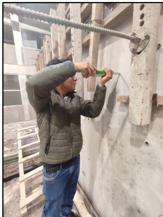
Fotografía 4. En la imagen se observa la utilización del esclerómetro para obtener la resistencia en campo a los 7 días de la estructura evaluada.
