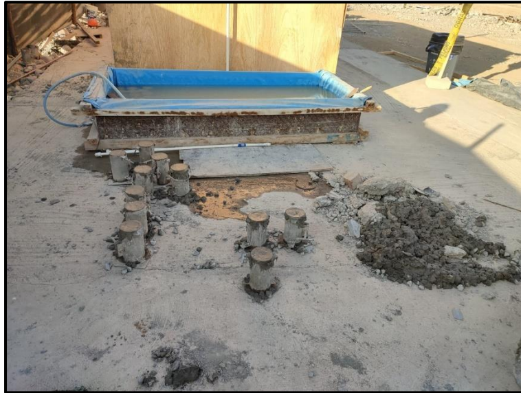
Fotografía 3. La imagen nos muestra las condiciones en las que se realizaron el muestreo en obra.
