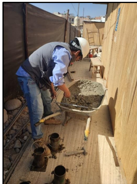
Fotografía 2. Se observa la elaboración de probetas cilíndricas de concreto en obra se realizaron 24 muestras.
