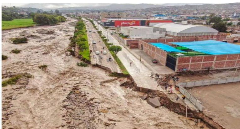
Destrucción de pavimentos y veredas
