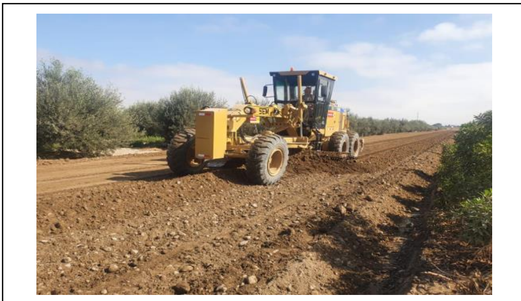
FOTO N° 7: FERFILAMIEN TO DE TRAMOS, MOVIMIENTO DE TIERRAS CON EL USO DE MAQUINARIA
