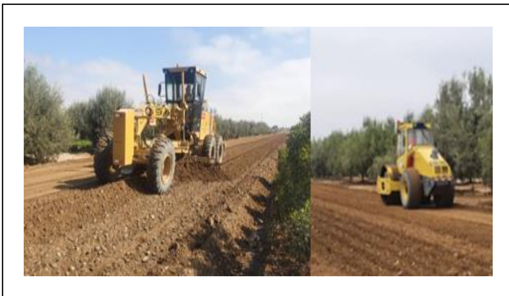
FOTO N° 9: NIVELACION Y COMPACTACION DE SUBRASANTE CON MAQUINARIA
