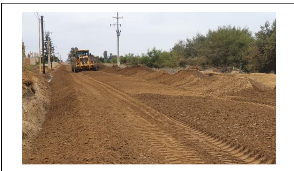
FOTO N° 8: COLOCACION DE BASES Y SUB BASES
