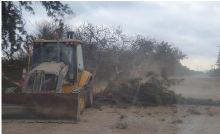
FOTO N° 6: CORTE Y DESBROCE DE VEGETACION CON MAQUINARIA EN ZONA DE BERMA.
