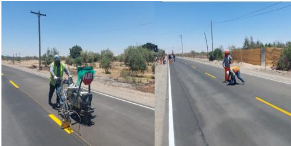
FOTO N° 12: PINTADO DE SEÑALIZACION HORIZONTAL DE TRÁFICO
