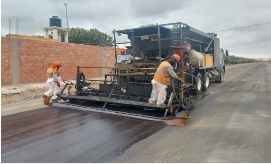
FOTO N° 11: COLOCACION DE PAVIMENTO ASFALTICO
