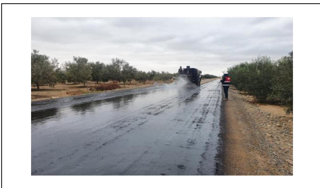
FOTO N° 10: APLICACIÓN DE IMPRIMACION ASFALTICA.
